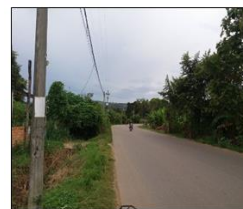
CARRETERA SECTOR OASIS
