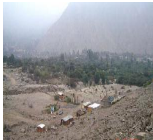
Figura I-2 Zona después del huaico
