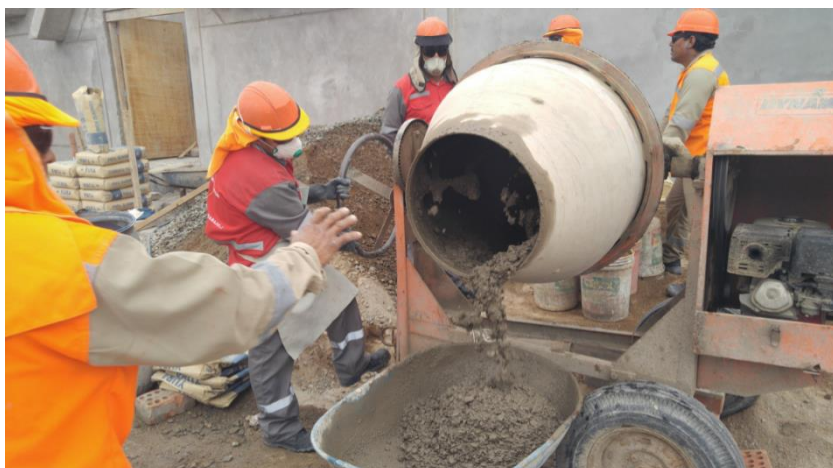
Figura 29. Preparación del concreto mezcla 1:8 e = 4" para falso piso.
