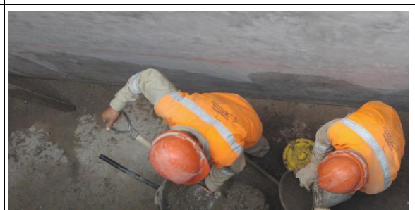
Vaciado al falso piso
