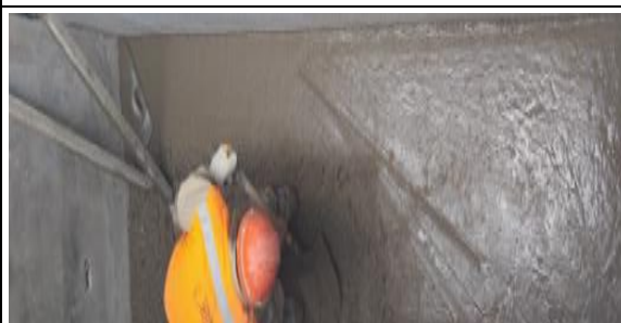
Esparcimiento del concreto
