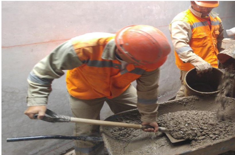
Figura 28. Vaciado de concreto al falso piso.
