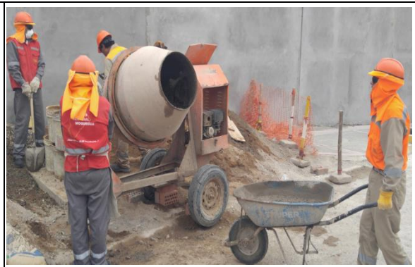
Preparación de la mezcla del concreto
