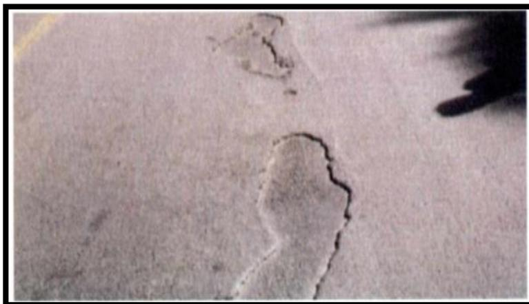
Imagen: Falla por peladura o descascamiento
