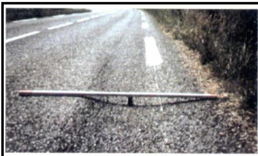
Imagen: Deformación por deficiencia estructural
