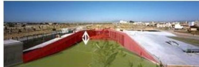
La altura de la volumetría es de un solo nivel, para poder integrarse a la topografía sin resaltar en la altura.
