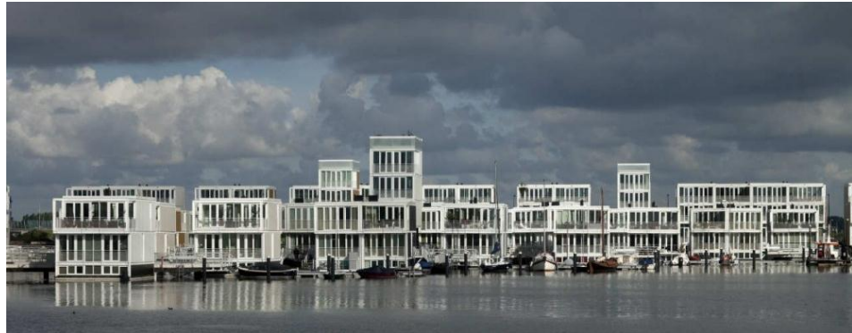
Figura 19: Vista Frontal del Complejo Ijburg.
