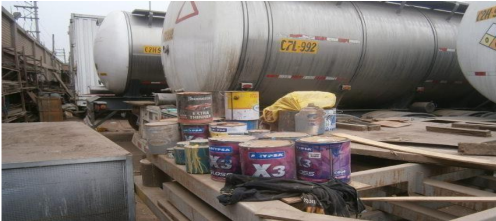
FIGURA N° 20 – PINTURAS ALMACENADAS INADECUADAMENTE
