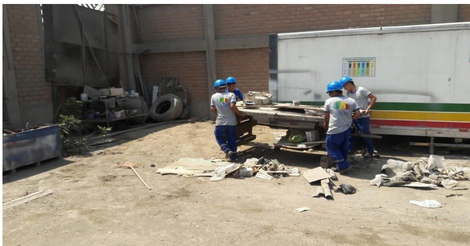
FIGURA N° 30 – LIMPIEZA DE ÁREA DE ESTRUCTURAS
