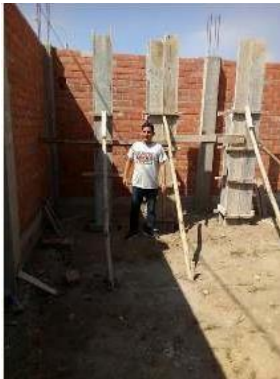
Figura 13: Encofrado de columnas
