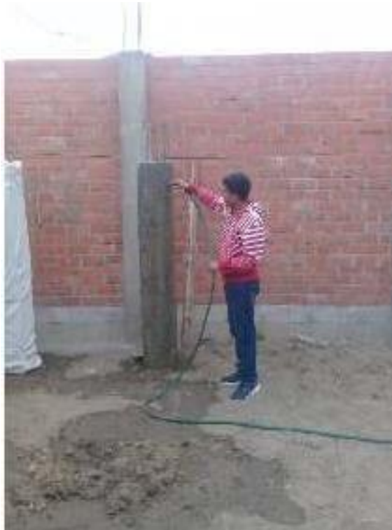
Figura 17: Curado de Elementos verticales
