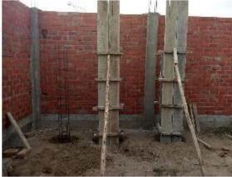
Figura 12: Encofrado de columnas
