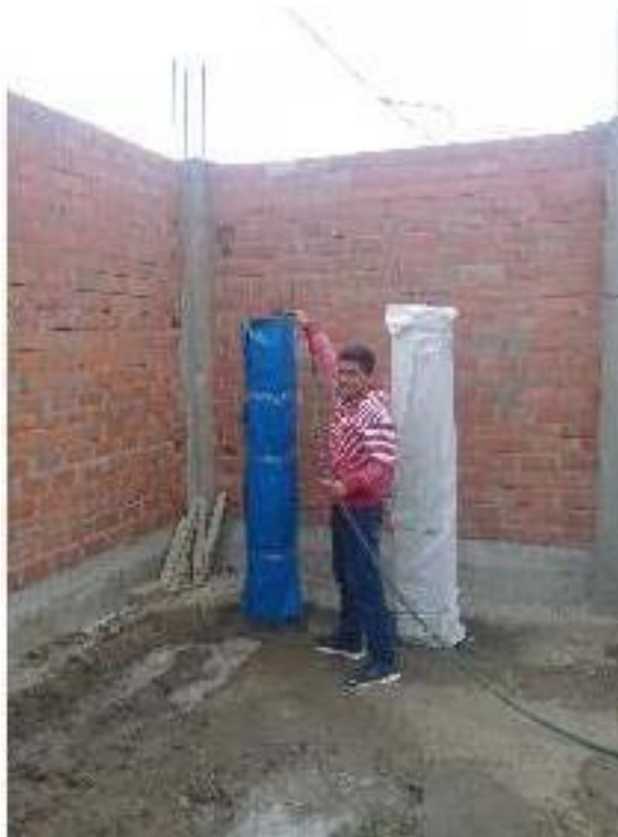
Figura 15: Curado de Elementos verticales
