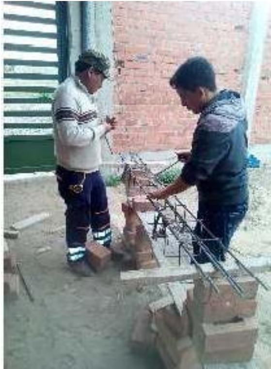
Figura 11: Ejecución de Armadura para Columnas
