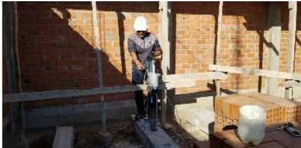
Figura 23: Extracción de Núcleos de concreto
