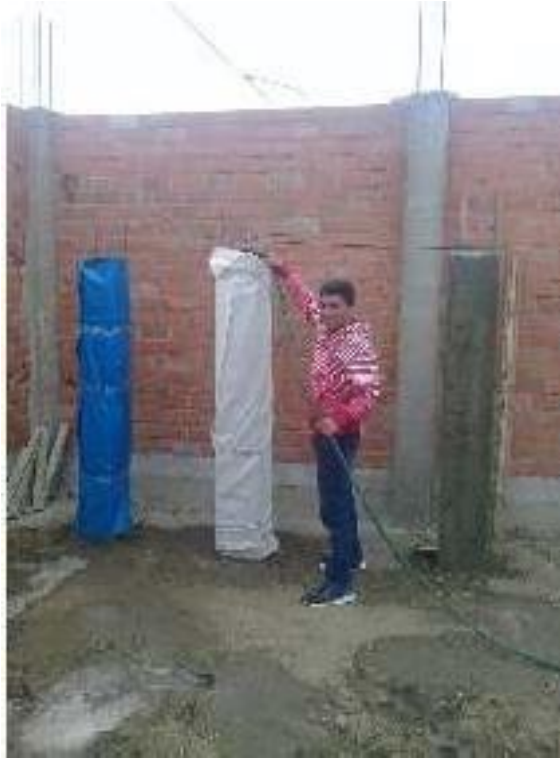
Figura 16: Curado de Elementos verticales
