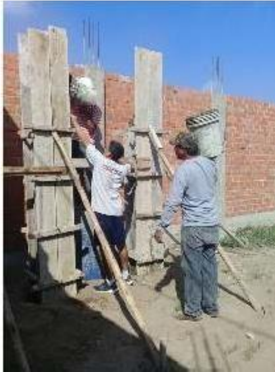
Figura 14: Realizando el vaciado
