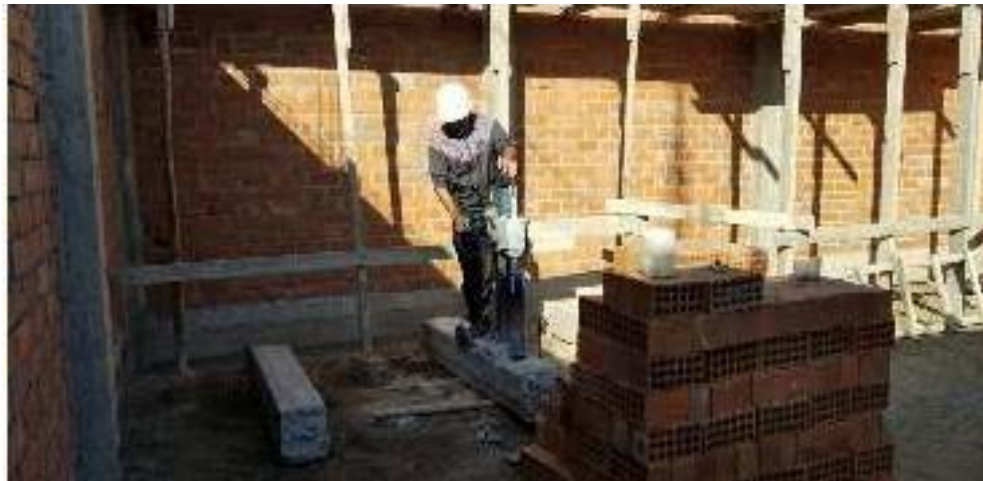
Figura 24: Extracción de Núcleos de concreto
