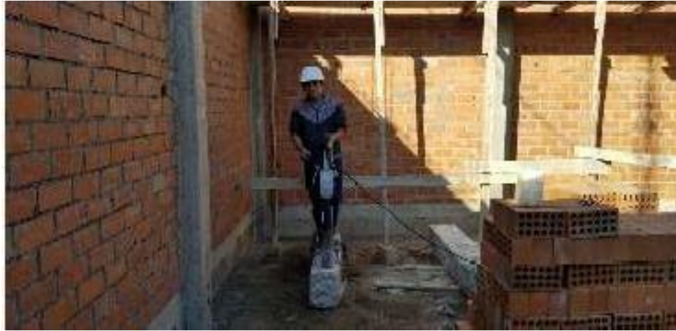
Figura 22: Extracción de Núcleos de concreto
