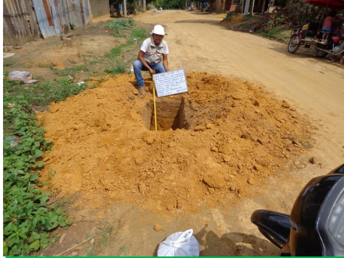
VISTA PANORAMICA DE LA CALICATA
