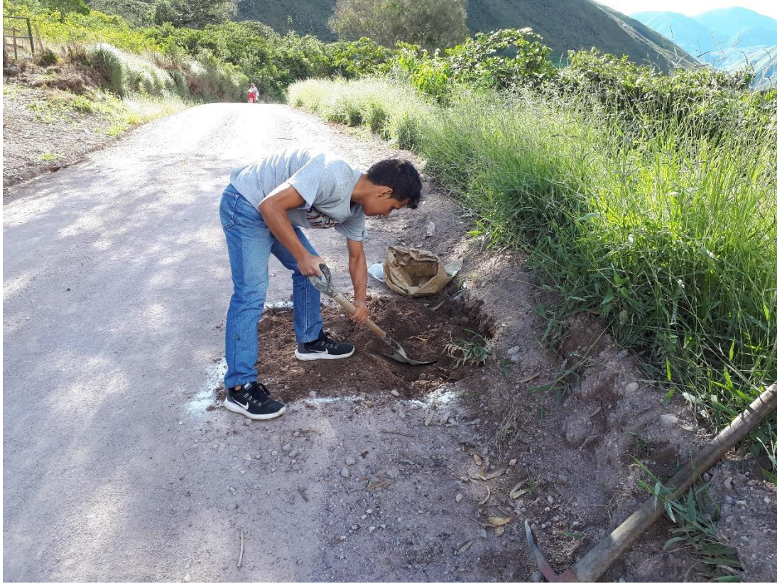
Figura 18. Extracción de terreno natural.
