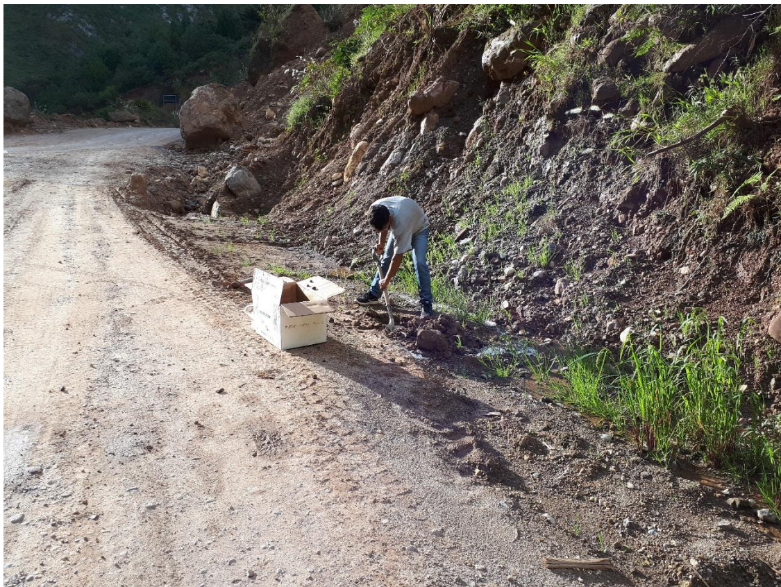
Figura 25. Extracción de terreno natural.
