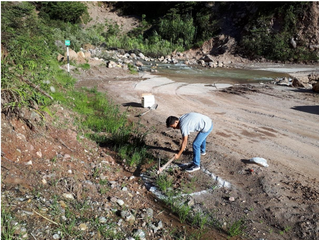
Figura 23. Picado del terreno.
