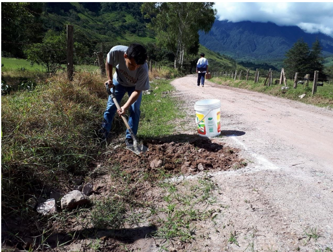
Figura 13. Extracción del terreno natural.
