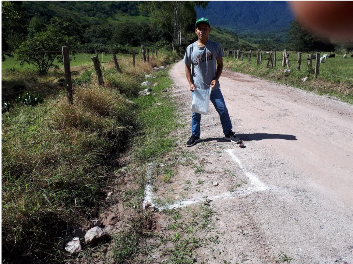
Figura 11. Marcado con cal el perímetro del área.
