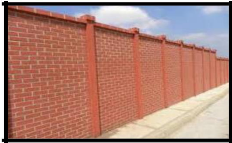
Figura 12: Muros de albañilería
