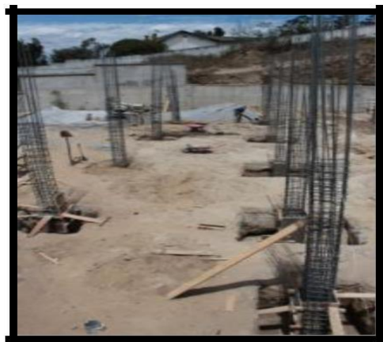
Figura 11: plantado de columnas
