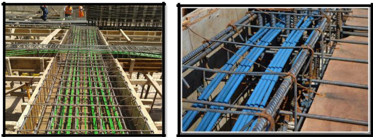
Figura 18: Encofrado de vigas postensadas.
