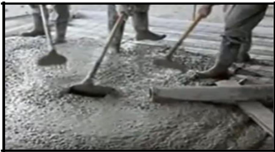
Figura 3: Mezclado manual de concreto para postensado
