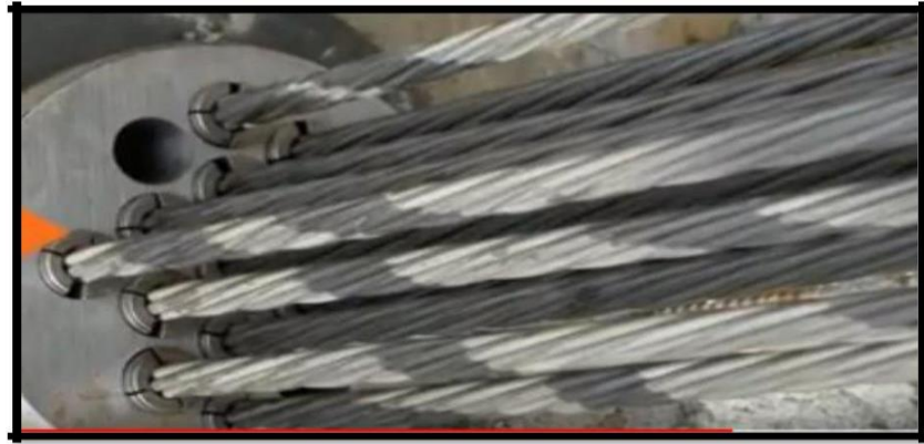
Figura 4: Torones o cables de postensado
