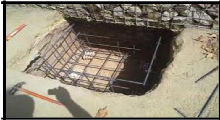
Figura 10: Cimentación de albañilería confinada
