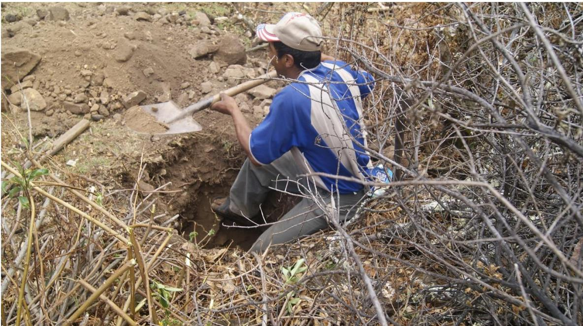
**Foto N°14 Excavación de calicata**
