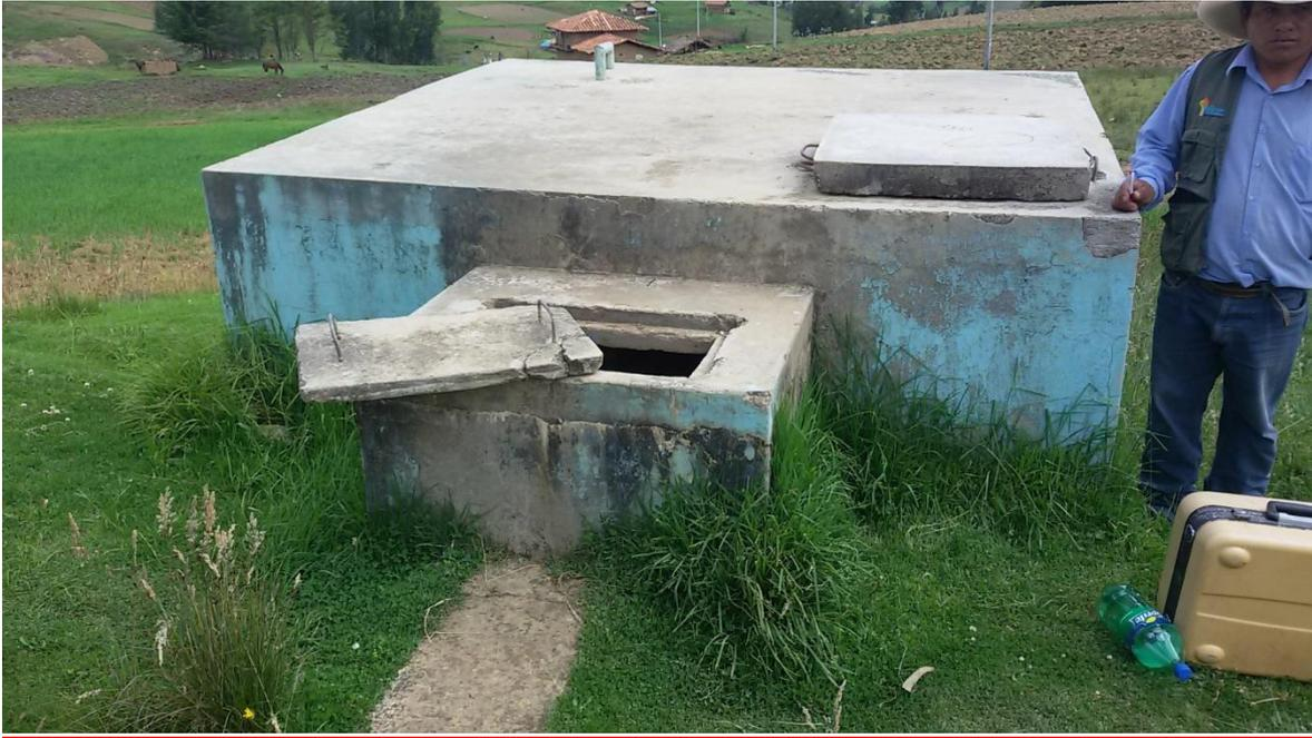
**Foto N°10 Reservorio existente rectangular**
