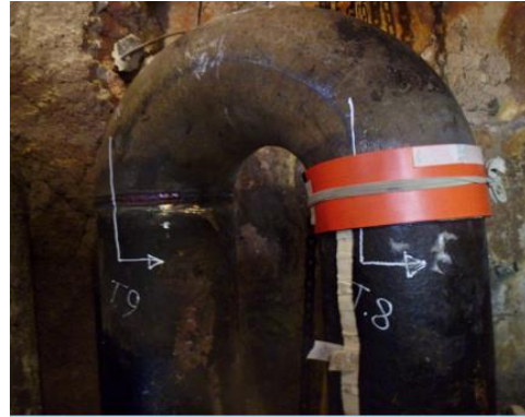
Figura 17. Trabajos de gammagrafía industrial Fuente: elaboración propia.
