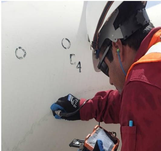
Figura 12. Trabajos de medición de espesores. Fuente: elaboración propia.
