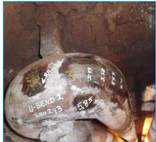
Figura 13. Trabajos de medición de espesores. Fuente: elaboración propia.
