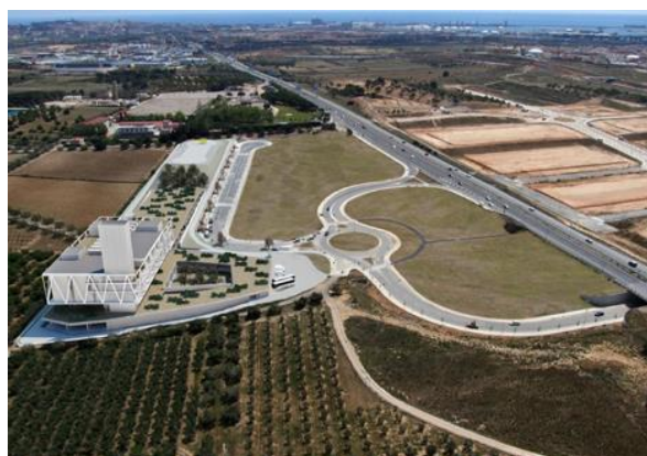
Figura 23: Vista general del proyecto
