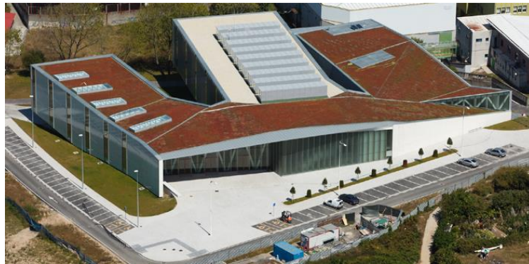
Figura 34: Vista general del proyecto
