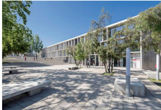
Figura 27: Vista desde la calle
