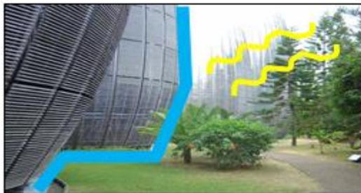
El diseño del proyecto tiene la intención de aprovechar los vientos naturales que vienen del Océano Pacífico. La fachada exterior está compuesta de madera, los filtros del viento en una segunda capa de persianas de vidrio, que puede abrir y cerrar la ventilación natural.
