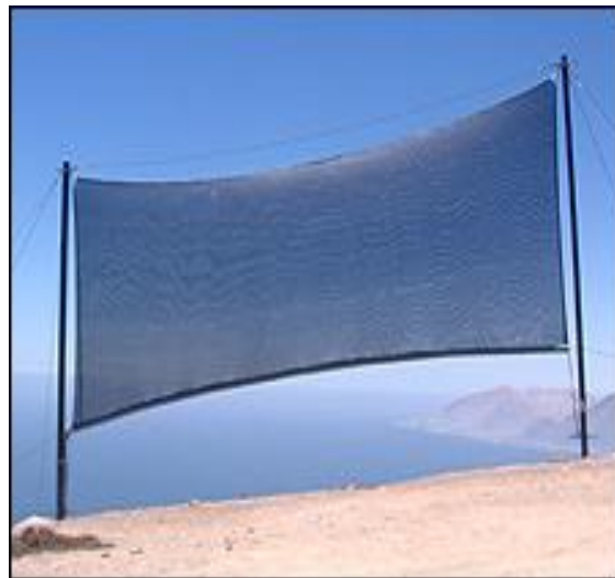
Estructura de maderas con la malla Raschell
