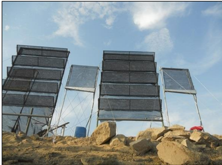
Estructura con fierro galvanizado con malla de material inoxidable y galvanizado
