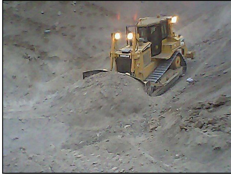
Figura 37. Abastecimiento de Tierra
