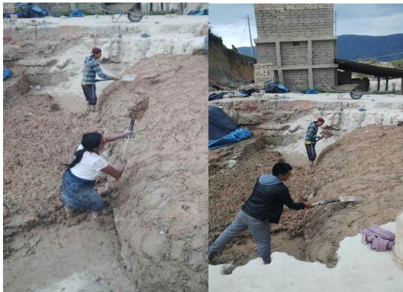
Ilustración 2. Preparación de la tierra arcilla
