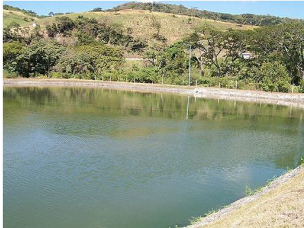
Figura N°22: Laguna de Maduración
