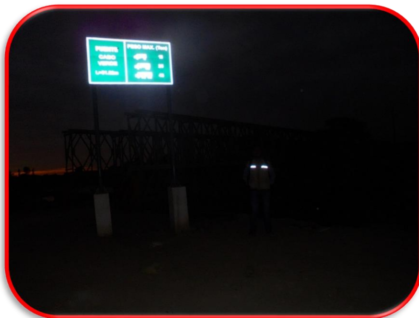
Figura N° 23: Puente Cabo Verde – Entrada principal
