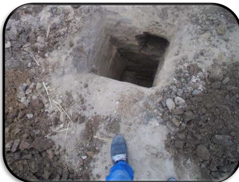
Figura N° 32: Calicata N° 1 Laguna de Oxidación
