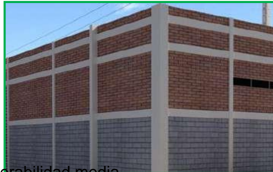
FIGURA N° 32 Muros confinados y reforzados
