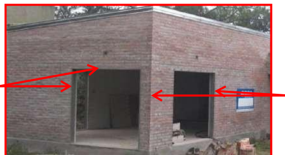
FIGURA N° 34 Muros confinados y reforzados
