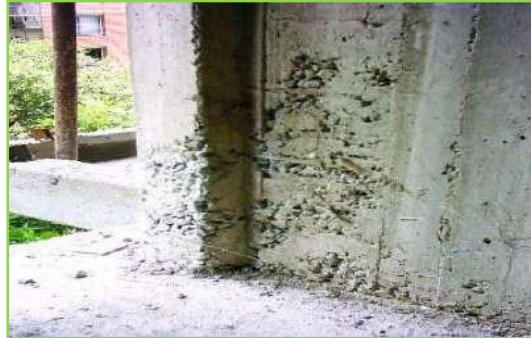
FIGURA N° 7 Vibrado insuficiente
