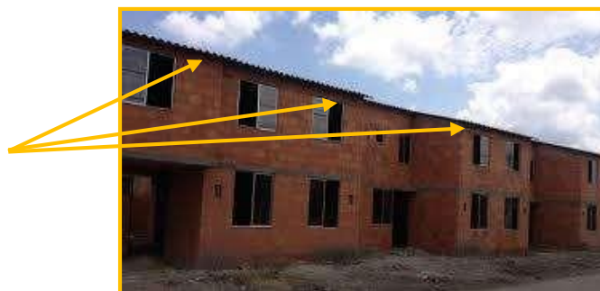
FIGURA N° 39 Vigas de amarre
