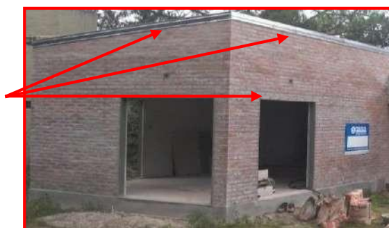
FIGURA N° 40 Vigas de amarre
