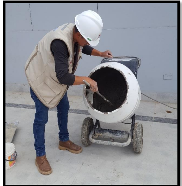
Figura 23: Mezclado de agregado.
