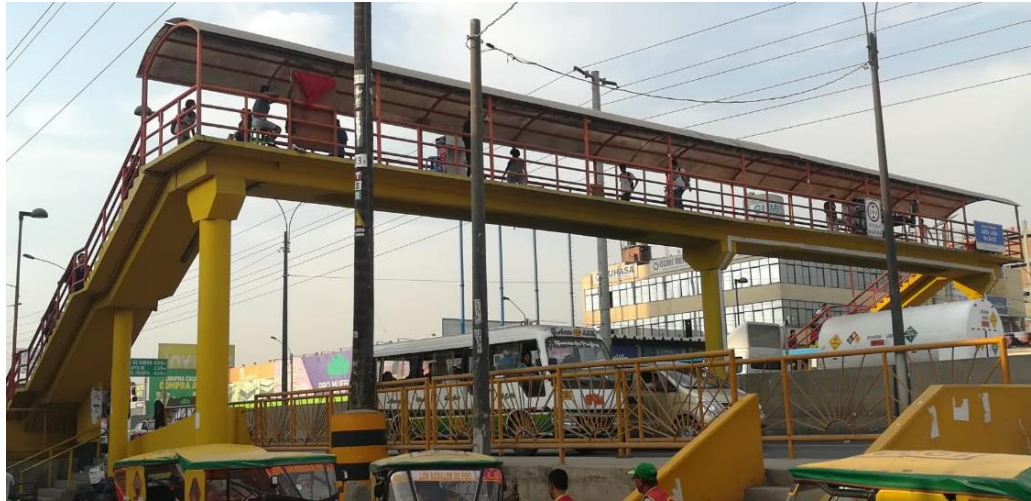
Figura III-39: Vista panorámica del puente Santa Luisa. Fuente: Elaboración propia.
