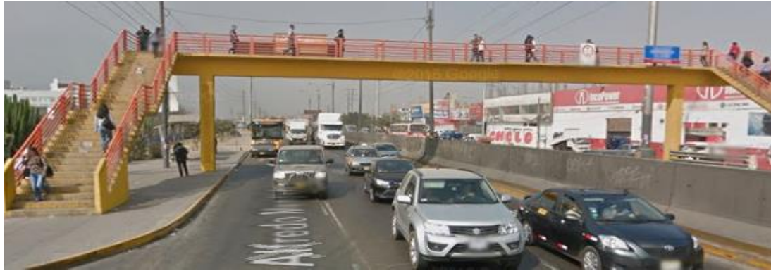
Figura III-2: Vista panorámica del puente peatonal bajo estudio. Fuente: Elaboración propia.
