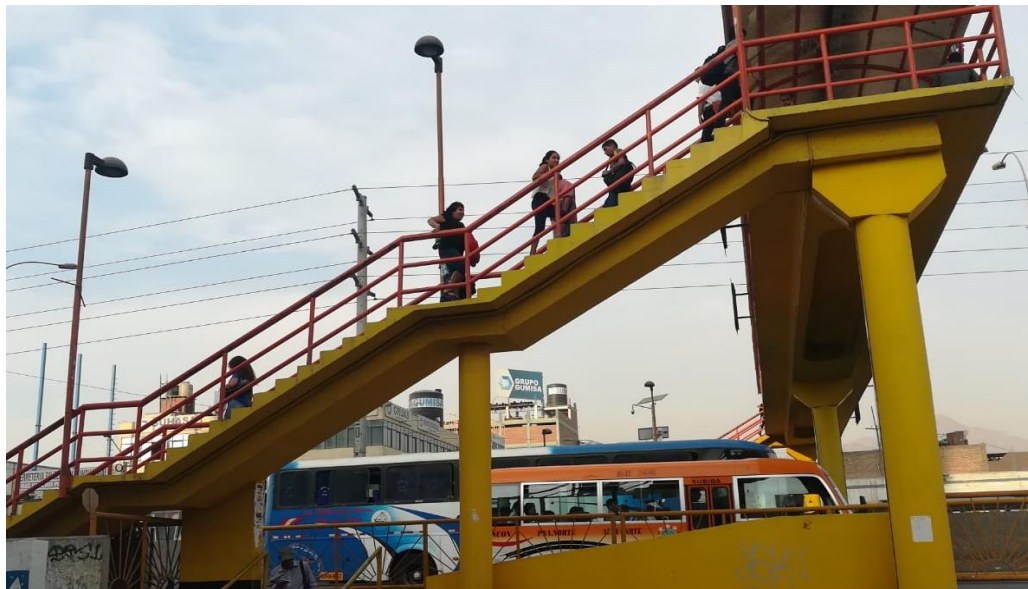
Figura III-40: Vista lateral del puente Santa Luisa. Fuente: Elaboración propia.
