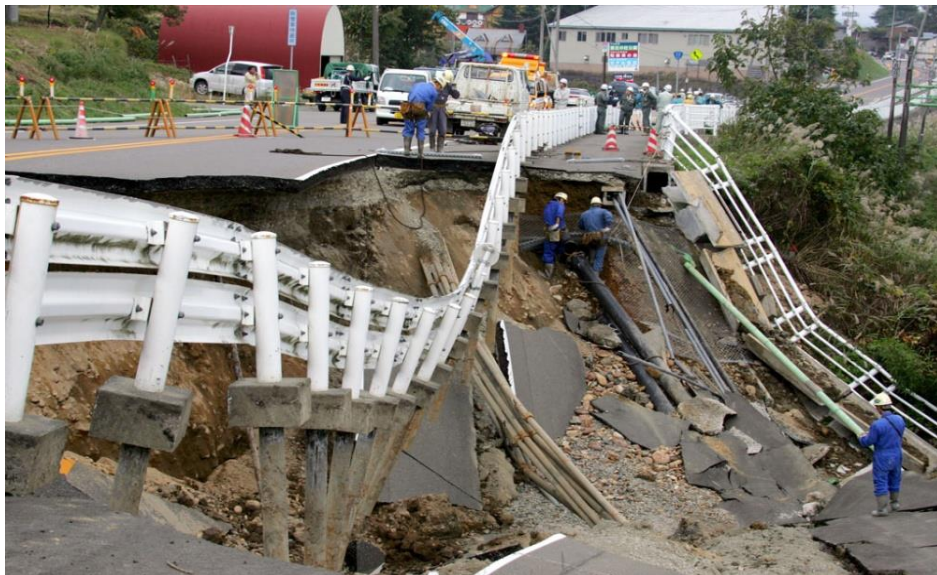
Figura I-1: Colapso de puentes debido a la acción sísmica.
