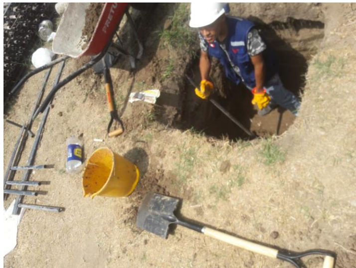
Figura 3 cavado de hoyos
