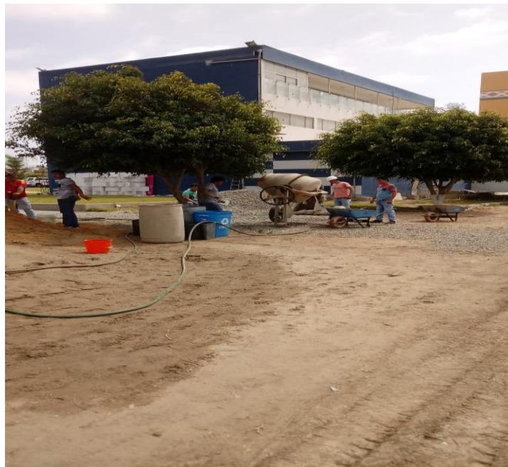
Figura 6.Preparación de la mezcla de concreto.
