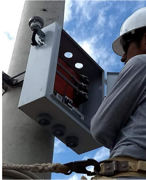
Fig 16. Montaje de tablero de distribución
