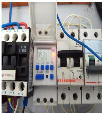
Fig 14. Programación de interruptor horario digital
