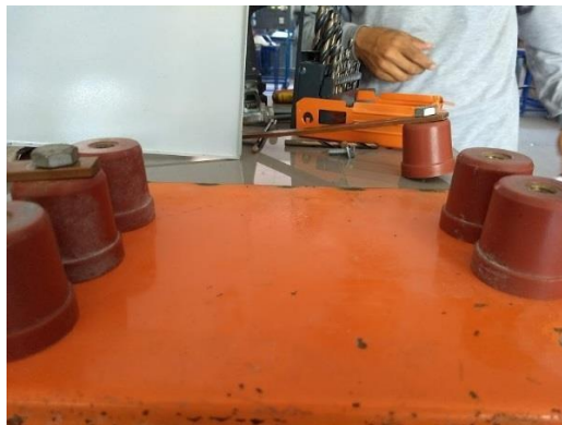
Fig 9. Montaje de aisladores de porcelana
