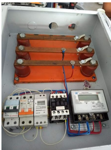
Fig 13. Montaje e instalación interruptores termo-magnéticos
