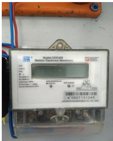
Fig 12. Montaje e instalación de medidor electrónico
