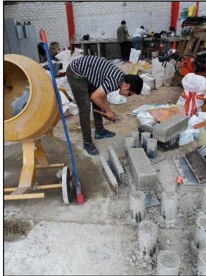
Figura 25. Desencofrado de muestras de concreto.
