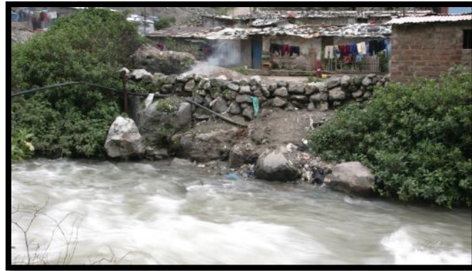
Figura 63: Viviendas ubicadas en la ribera del río. (Fuente: Google)
