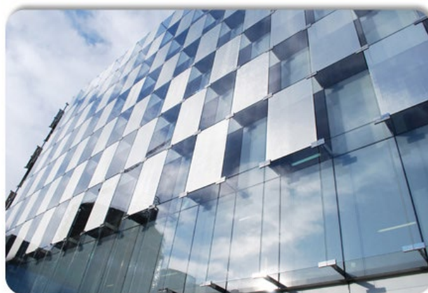
Imagen 69. Fachada fotovoltaica doble piel. Recuperado de: Vitro
