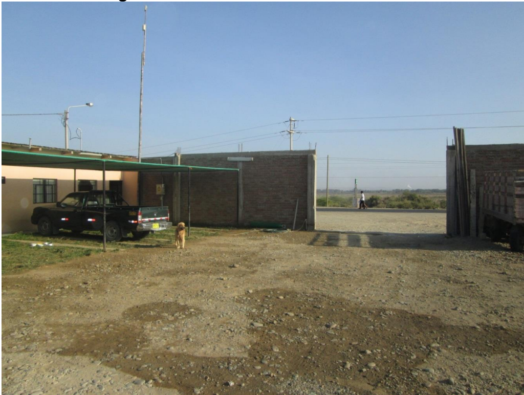
Figura 24: Entrada del taller Metalmecánico
