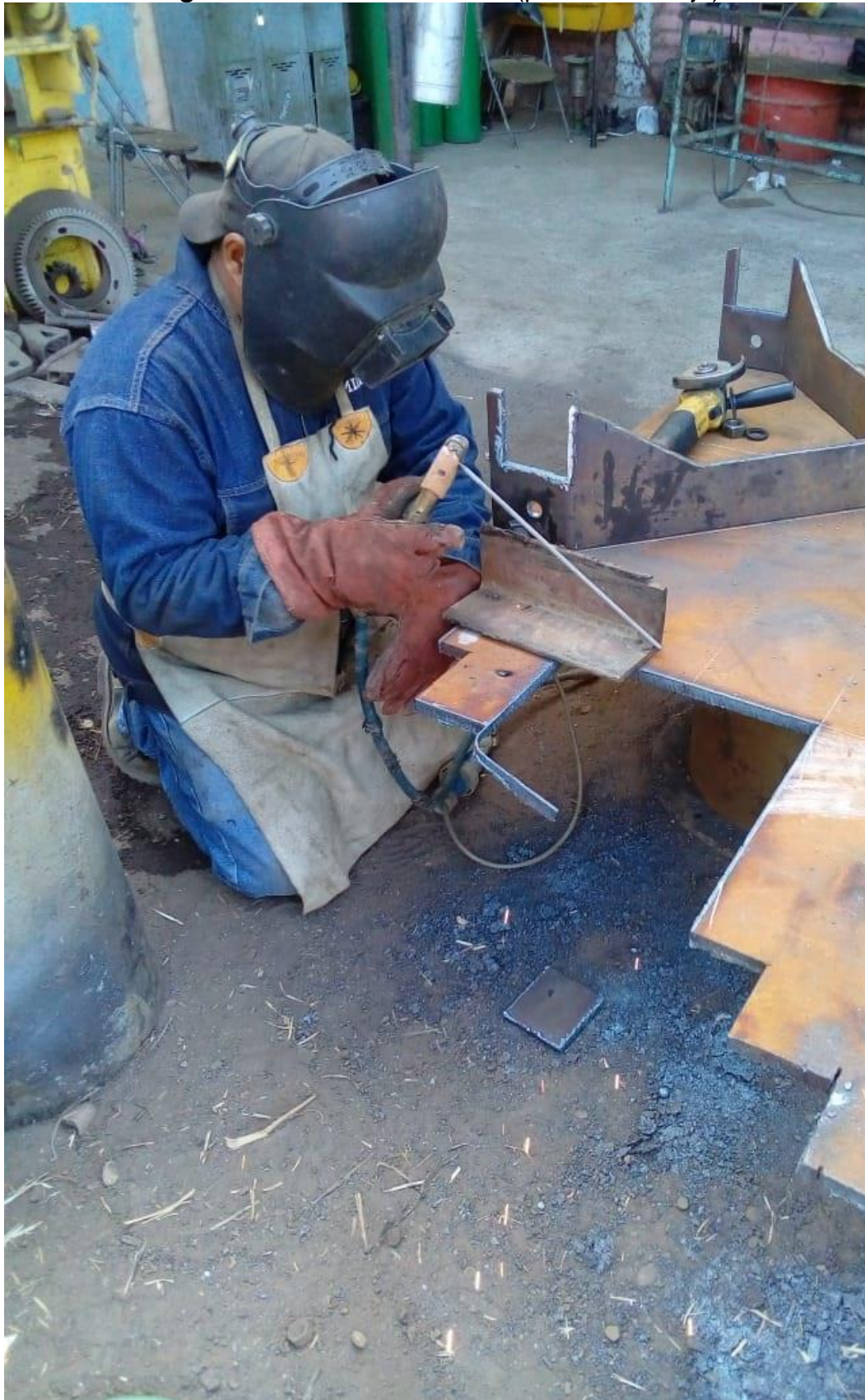
Figura 22: Área de Soldadura (previo al trabajo)
