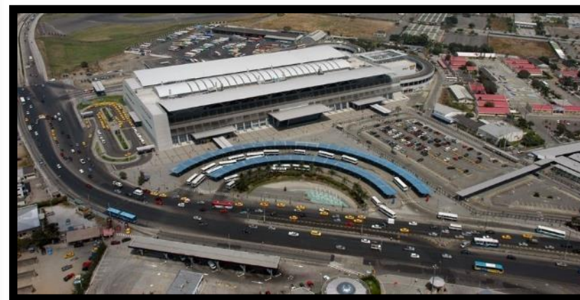
Principal vía de acceso de vehicular y
