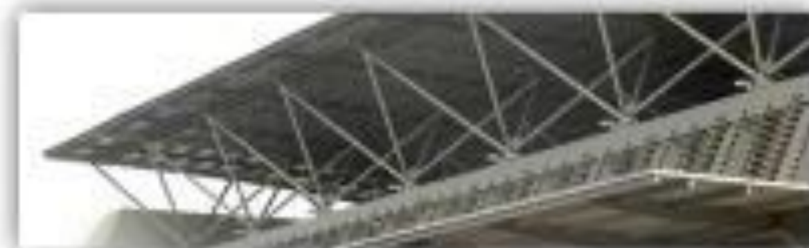
ESTRUCTURAS METALICAS EN "V"
