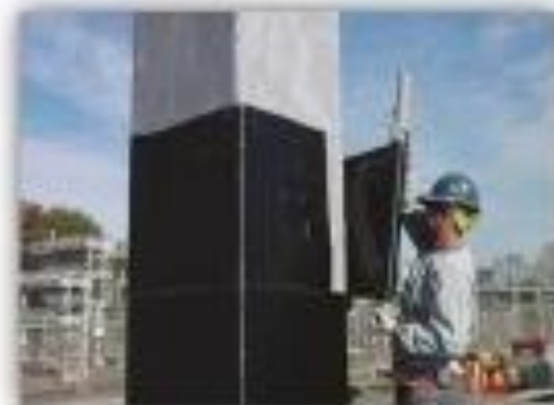
RECUBRIMIENTO DE COLUMNAS CON FIBRA DE CARBONO
