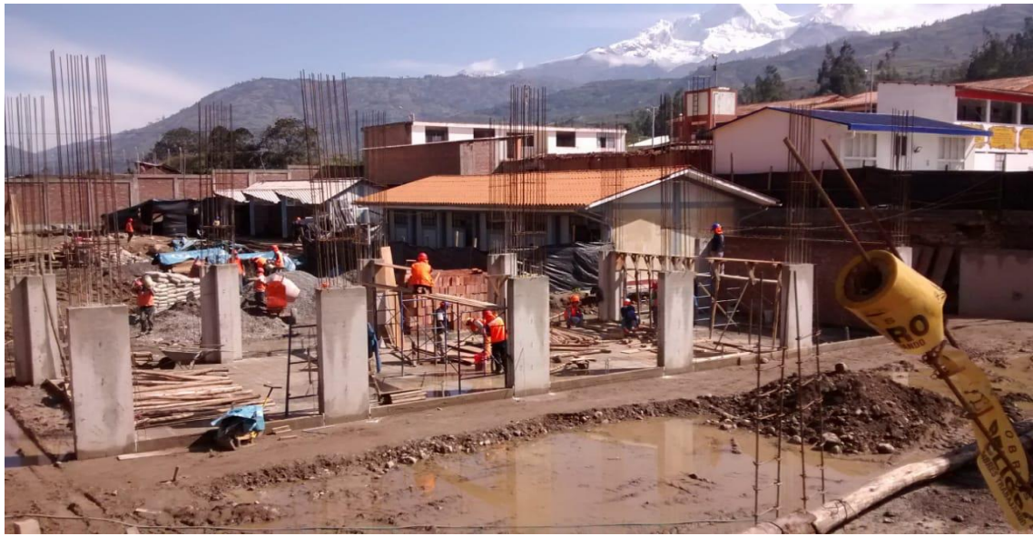
Vista de columnas ya baceadas y desencofradas .
