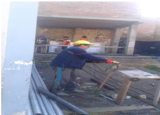
Fotografía de el trabajo de herreria y selección del acero.
