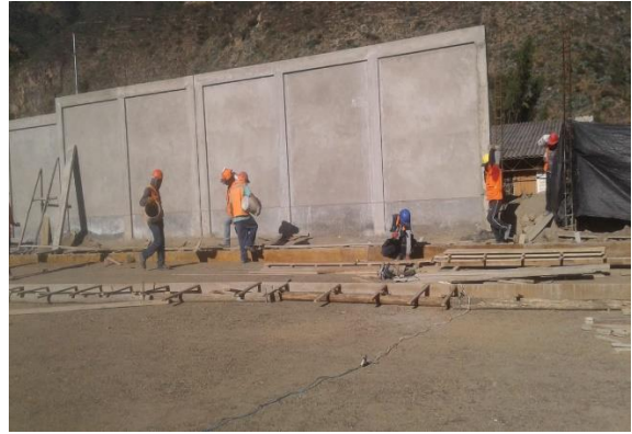
Imagen de encofrado para la losa deportiva.
