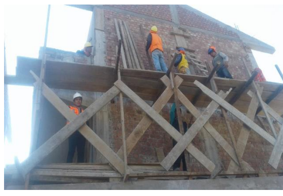
Imagen de supervición del andamio antes de comenzar el tarrajeo.
