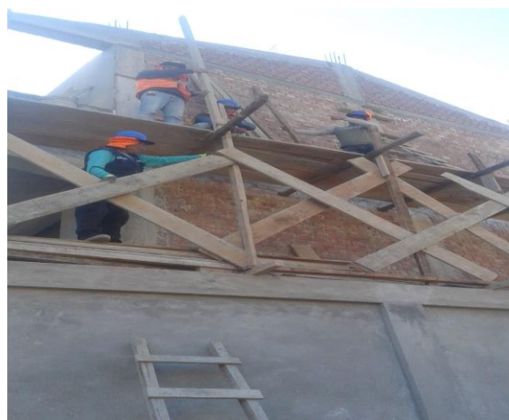
Imagen de supervición del andamio antes de comenzar el tarrajeo.
