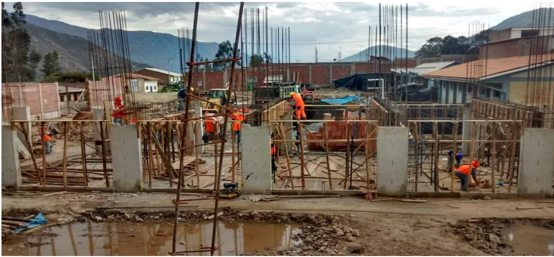
Vista de columnas ya baceadas y desencofradas .
