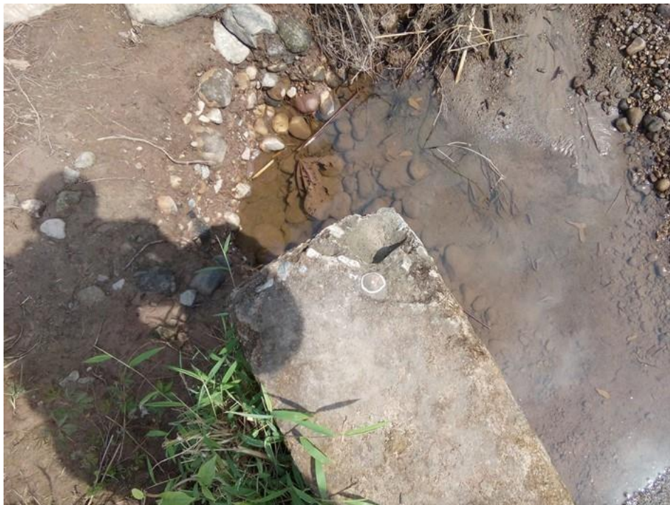
FOTOGRAFIA N° 02. Se aprecia el BM en el cabezal de alcantarilla existente.
