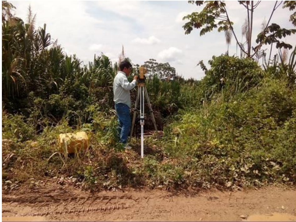
FOTOGRAFIA N° 01. Se aprecia al topógrafo realizando los trabajos de topografía.
