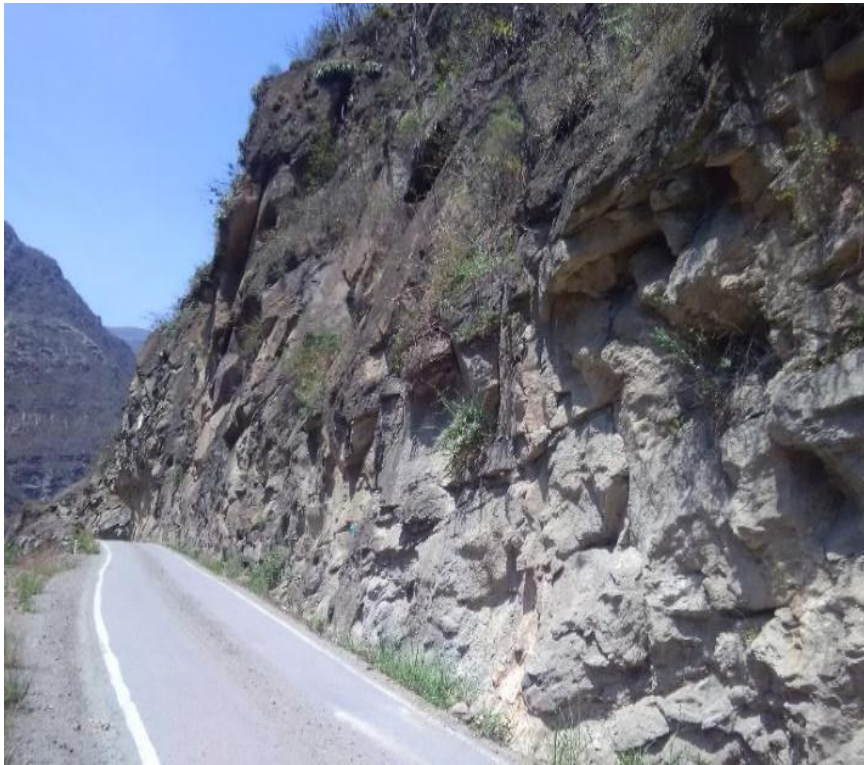
Figura 25: Afloramiento del macizo rocoso
