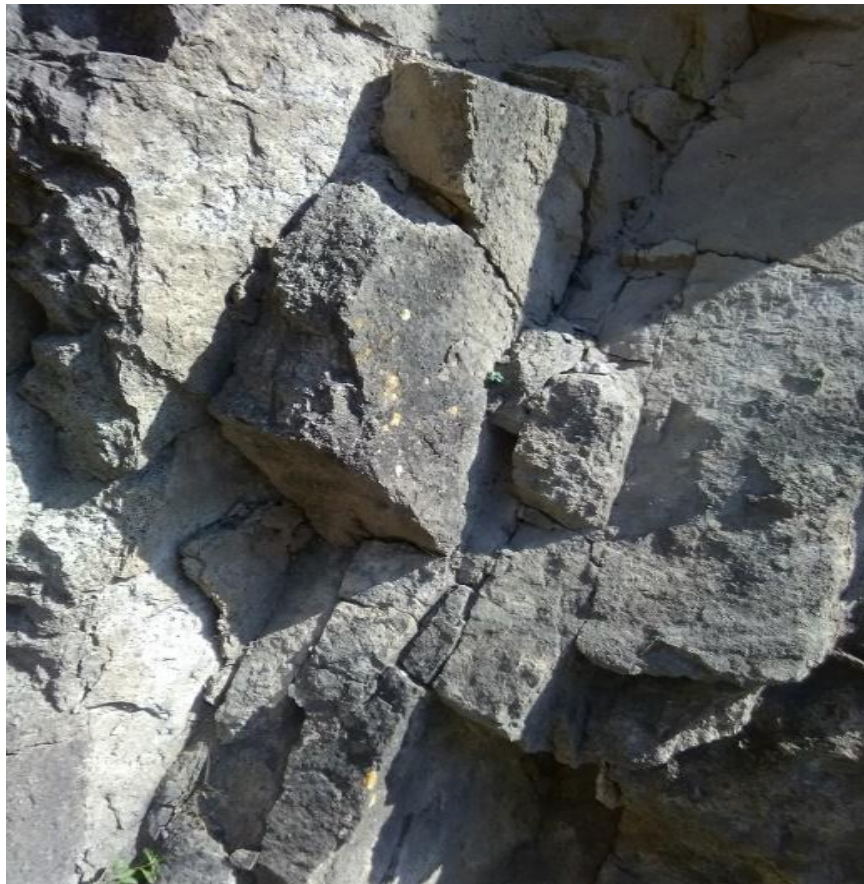
Figura 26: Bloques del macizo rocoso
