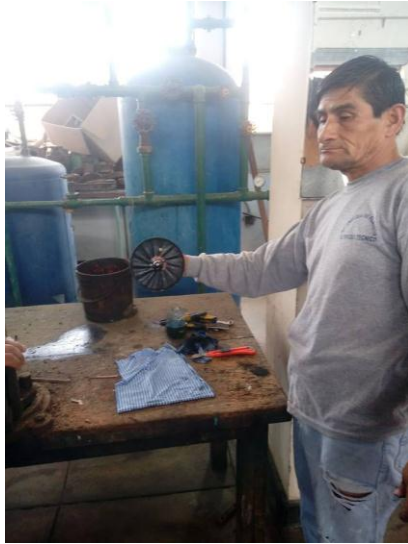
Figura 49: Mantenimiento al Caldero Fuente: Hospital Regional
