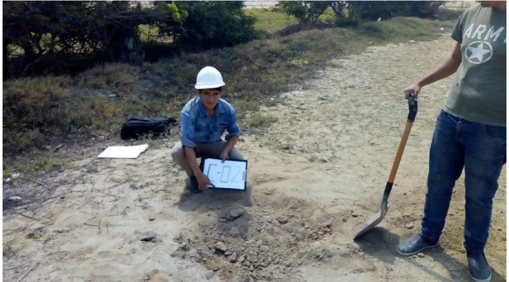
Fotografía de calicata N°2.
