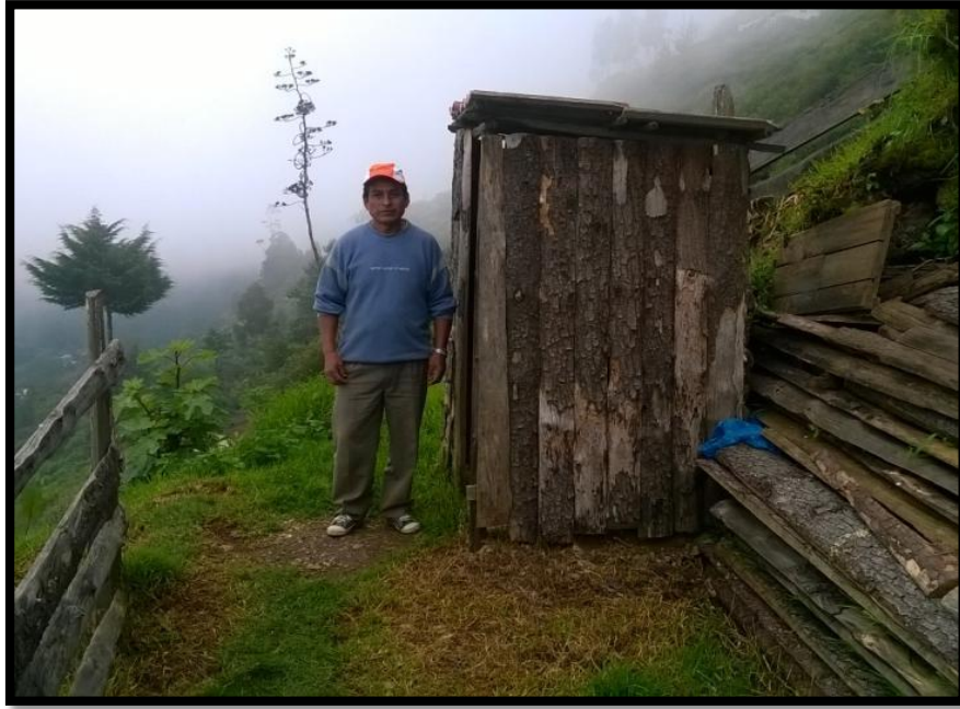
Figura 3: Se observa el estado de sistema de saneamiento en las algunas viviendas.
