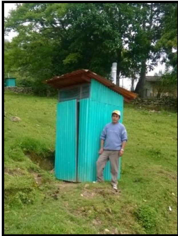
Figura 4: Se observa las condiciones actuales de las letrinas de Higospamba
