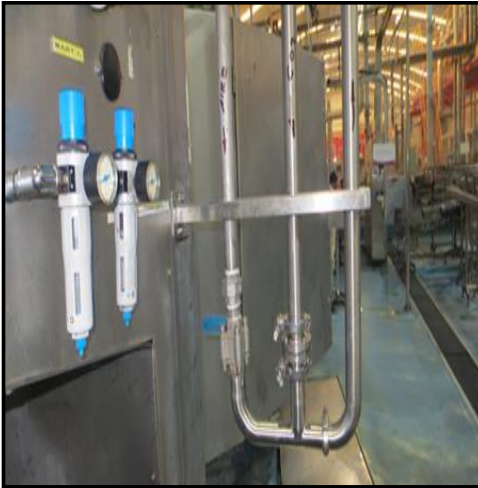
Figura 14: Reubicación de Tuberías de CO
