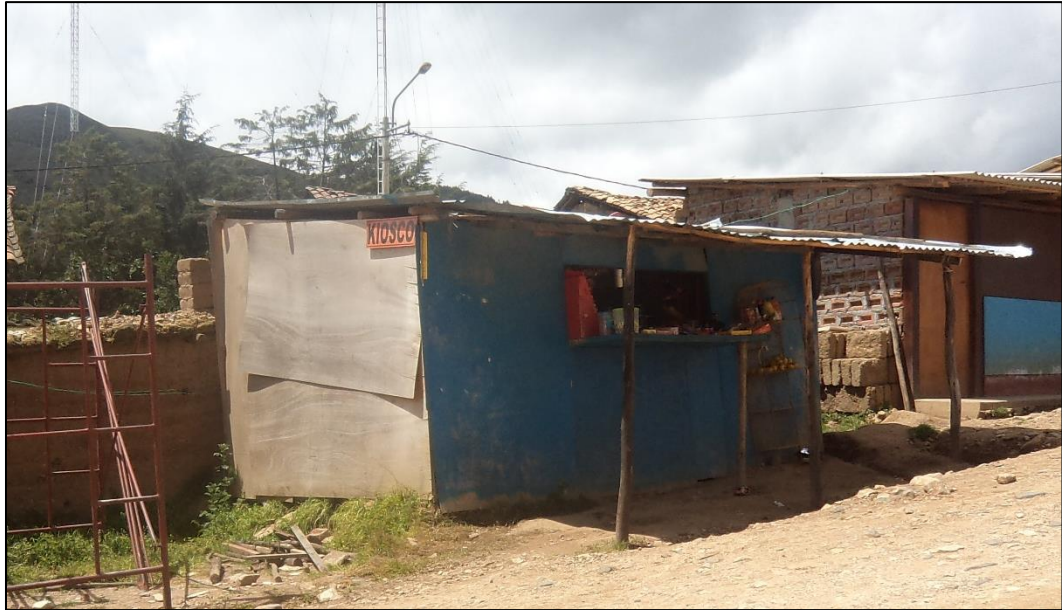
Figura 59. Quiosco construido improvisadamente con planchas de triplay y techado con calamina.
