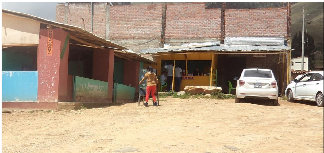
Figura 60. Restaurante ampliado en base a una construcción antigua existente, adicionándole planchas de triplay como separadores y la utilización de la calamina metálica para sus techos.
