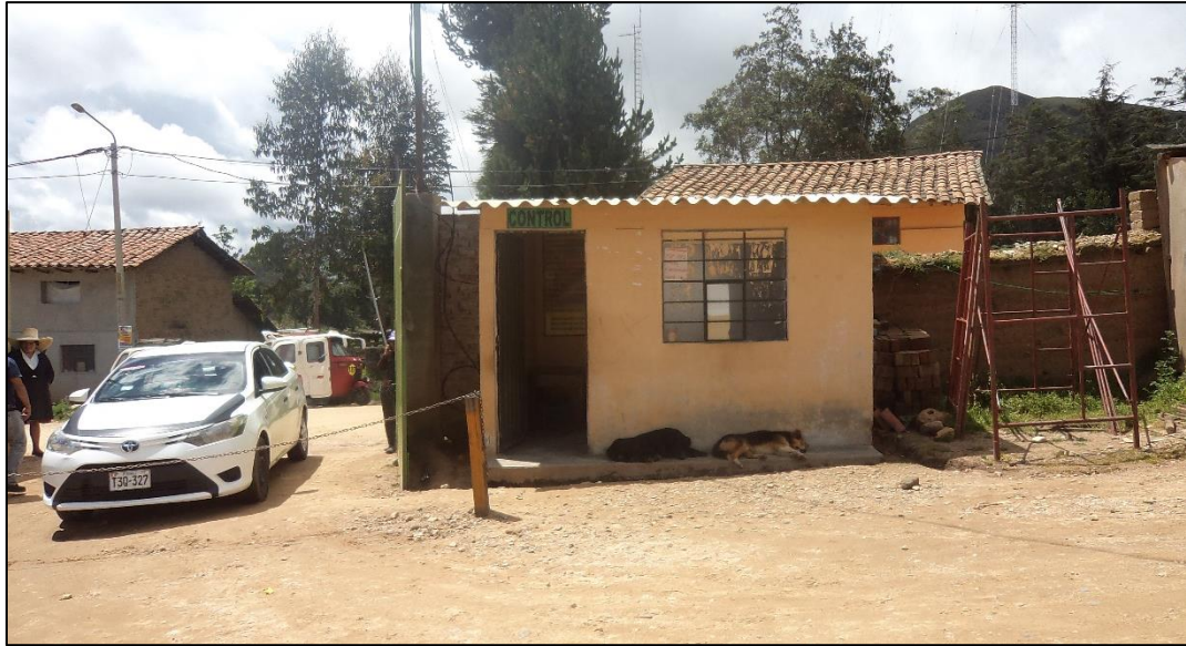
Figura 57. Control vehicular, construcción improvisada con ladrillo y techado con fibrocemento, que es utilizado para supervisar el ingreso de los vehículos, además de registrar su salida.
