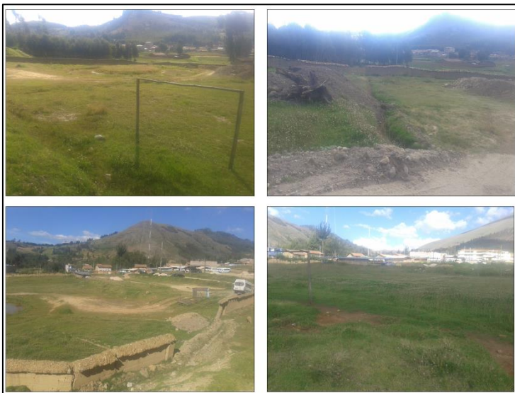
Figura N° 14. Fotografías del suelo del terreno seleccionado para el terminal terrestre. Fuente: Elaboración propia.
