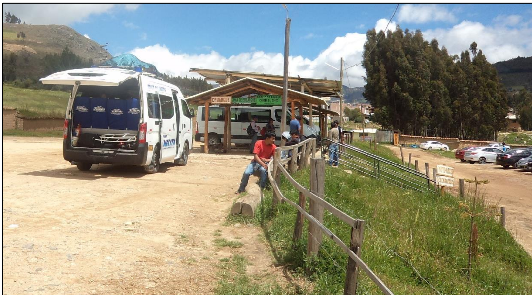
Figura 54. Zona de embarque y desembarque de pasajeros, estas instalaciones están construidas de madera y calamina, sin ningún tipo de control y seguridad, poniendo en riesgo a los pasajeros. Fuente: Elaboración propia.
