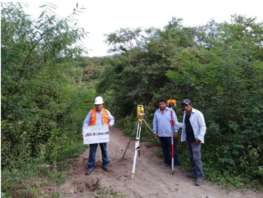
Fotografía 16. Levantamiento topográfico para línea de conducción
