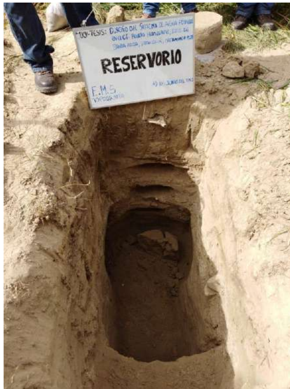
Fotografía 9. Detalle de exploración y muestreo para proyección de Reservorio
