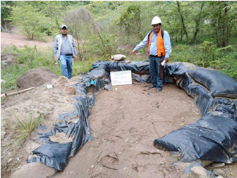
Fotografía 3. Captación existente, construido de manera empírica
