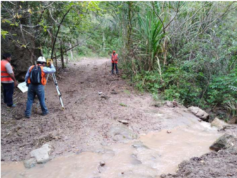
Fotografía 10. Levantamiento topográfico proyectado a línea de conducción
