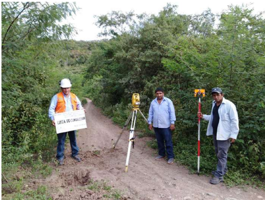
Fotografía 10. Proyección de líneas de conducción y aducción
