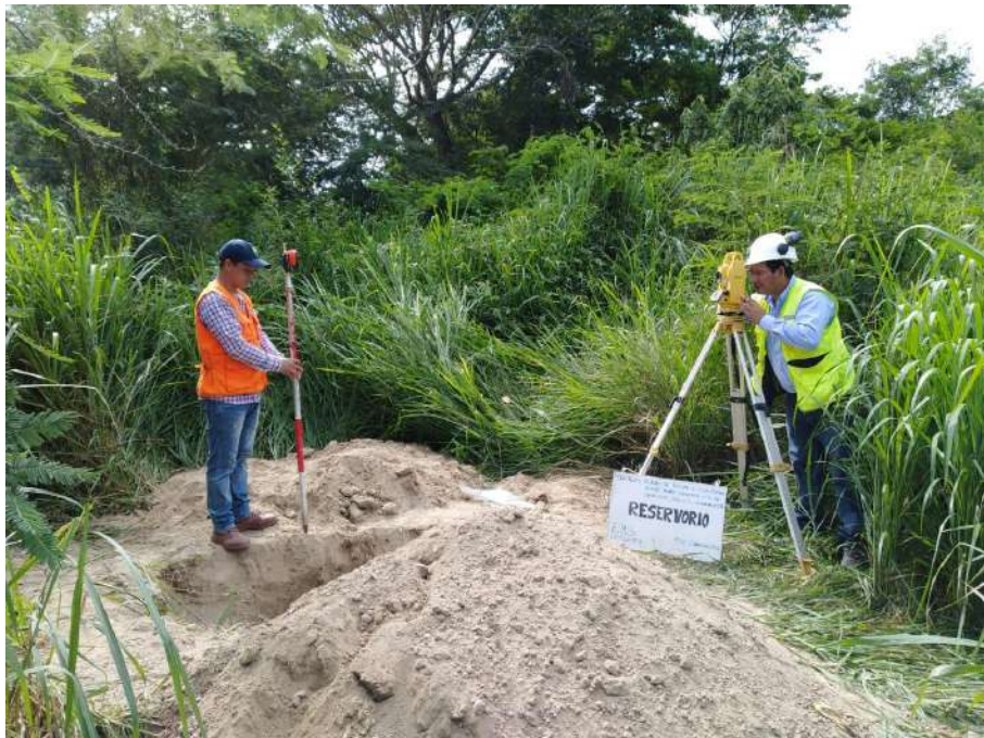
Fotografía 14. Proyección de área para estructura de reservorio
