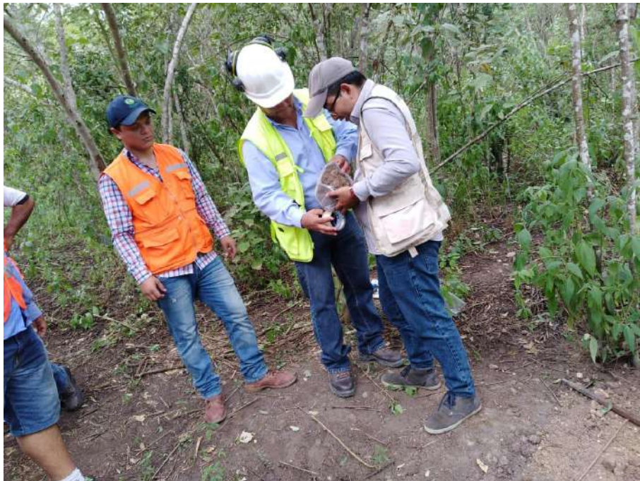
Fotografía 6. Vista detalle de muestreo para proyección de PTAP
