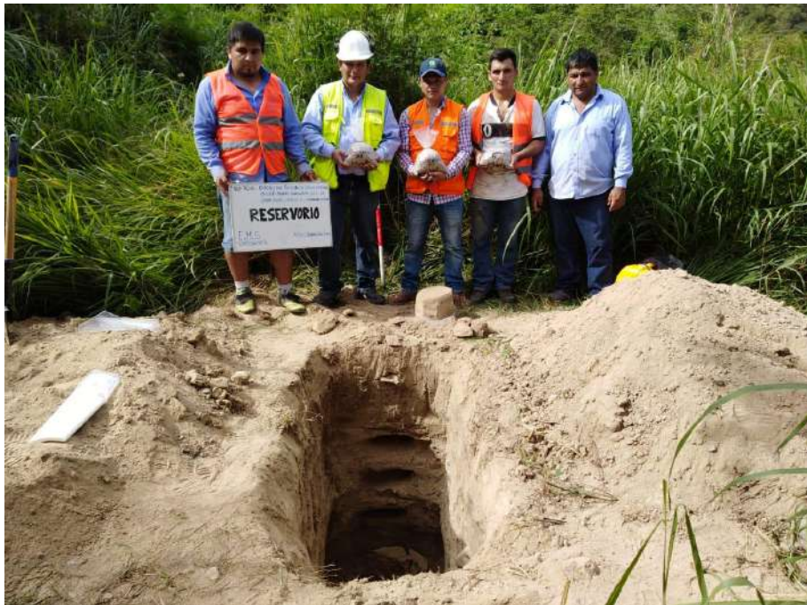
Fotografía 8. Detalle de punto de investigación para proyección de Reservoirio
