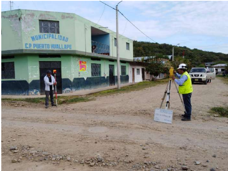
Fotografía 17. Levantamiento topográfico para línea de distribución al centro poblado Puerto Huallape
