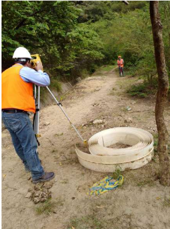
Fotografía 12. Levantamiento topográfico para línea de conducción paralelo a canal existente
