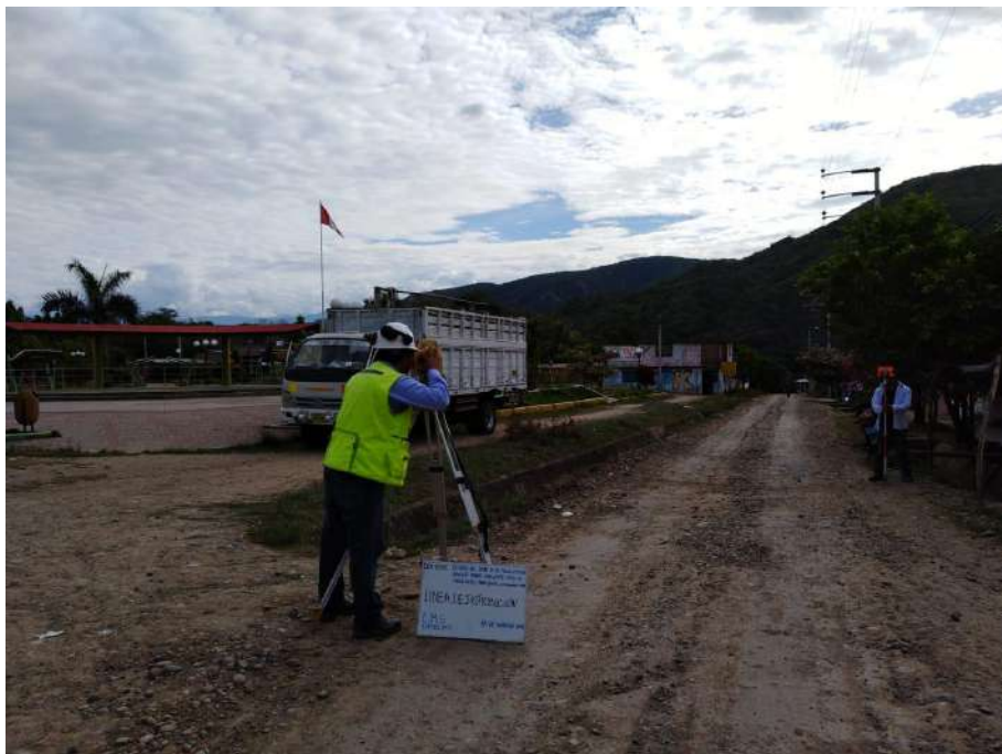
Fotografía 18. Levantamiento topográfico para línea de distribución al centro poblado Puerto Huallape
