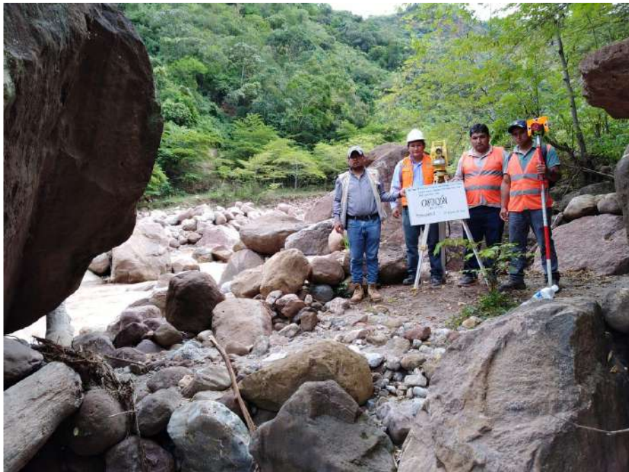
Fotografía 2. Levantamiento topográfico para proyección de estructura de captación
