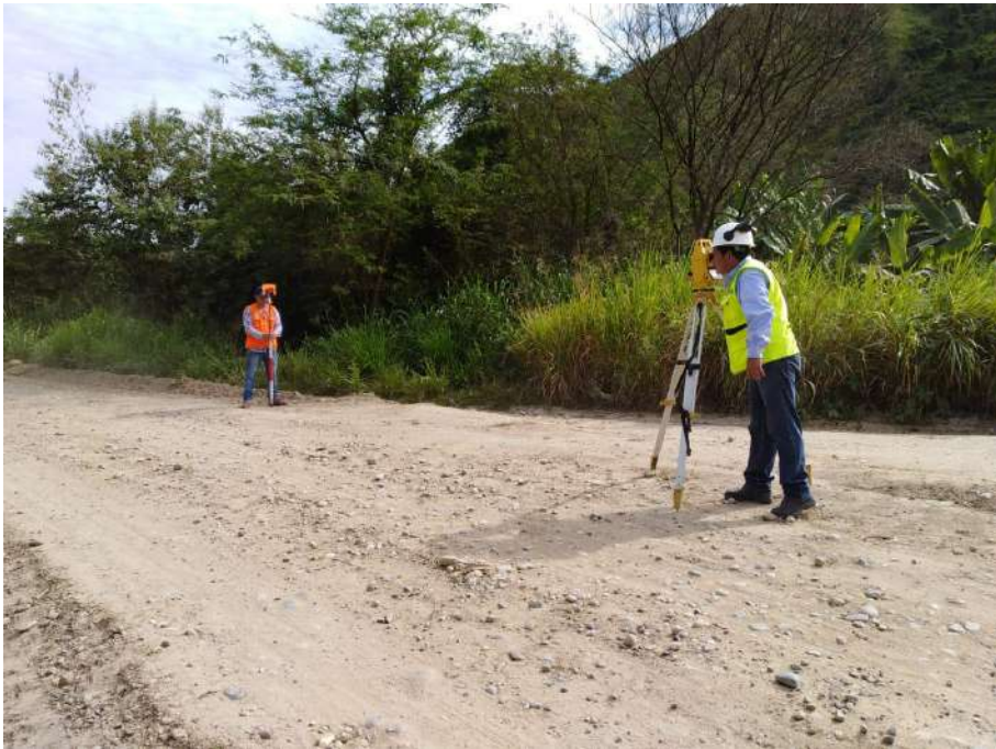
Fotografía 15. Levantamiento topográfico para línea de conducción
