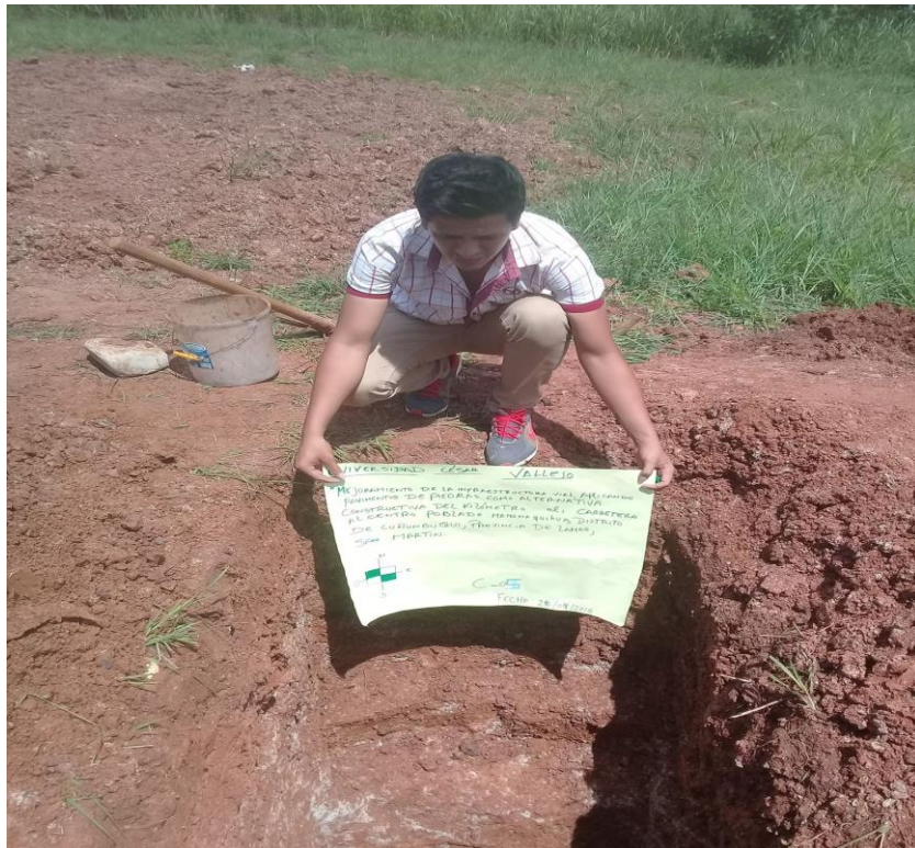
Figura 43. Excavación de la calicata C-05 en la vía de acceso al Centro Poblado de Mamonaquihua.
