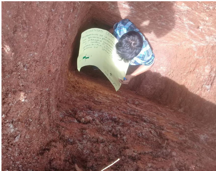
Figura 45. Excavación de la calicata C-10 en la vía de acceso al Centro Poblado de Mamonaquihua.
