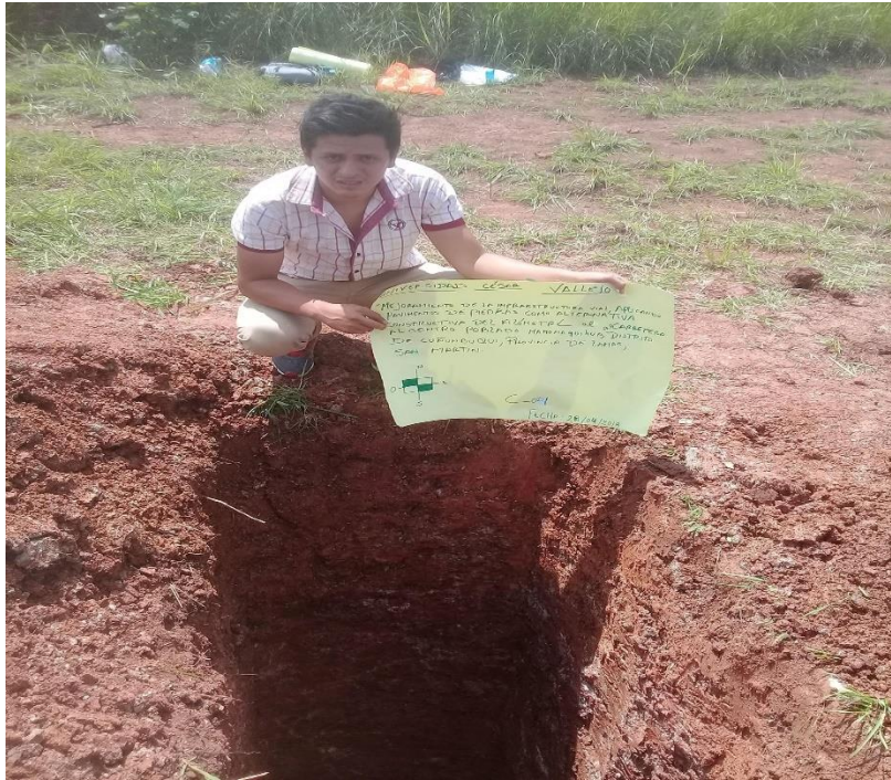
Figura 42. Excavación de la calicata C-04 en la vía de acceso al Centro Poblado de Mamonaquihua.
