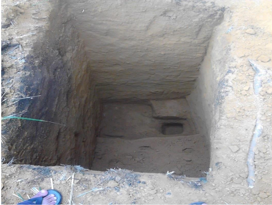
Figura 46. Toma de muestra de las calicatas en la vía de acceso al Centro Poblado de Mamonaquihua.
