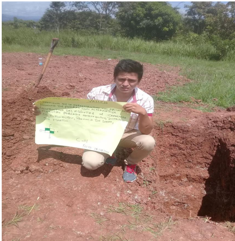
Figura 41. Excavación de la calicata C-01 en la vía de acceso al Centro Poblado de Mamonaquihua.
