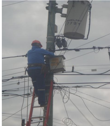
Figura 16. Instalación de totalizador
