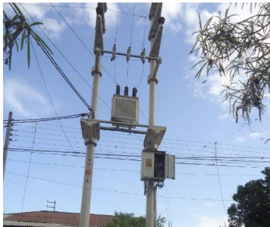
Figura 5. Vista panoramica SED 464115E
