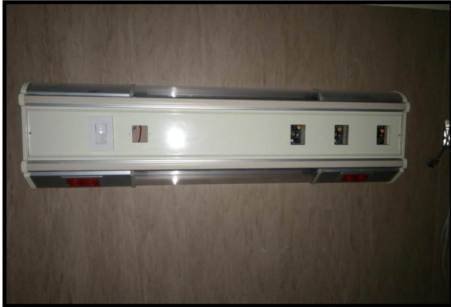
**Figura 15.** *Instalación de pulsador de cama*
