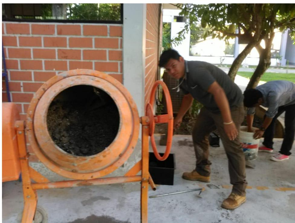
**Figura 56.** Preparación de la mezcla de concreto ligero.
