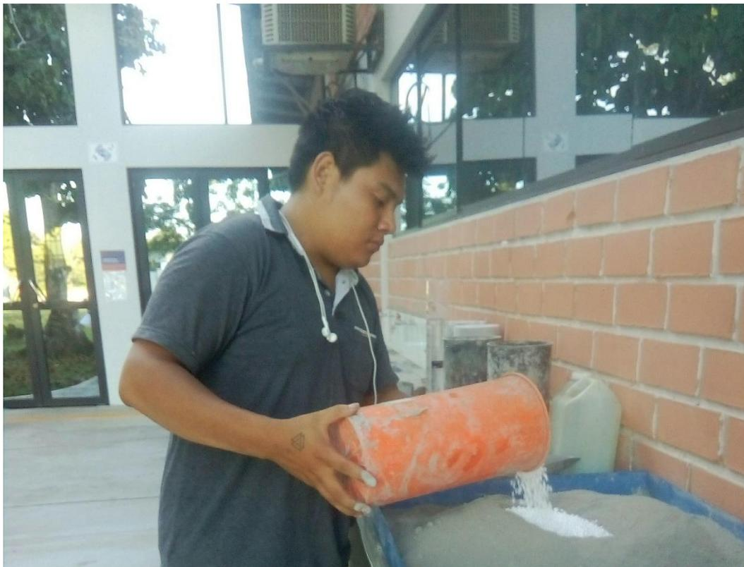
**Figura 44.** *Vertido de las perlas de poliestireno en la mezcla de concreto ligero.*
