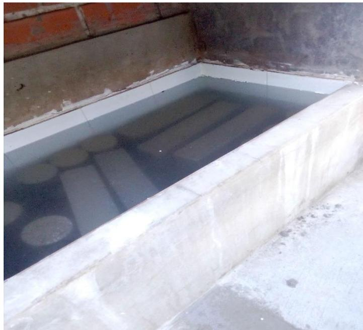
**Figura 58.** *Curado de los bloques de concreto ligero*
