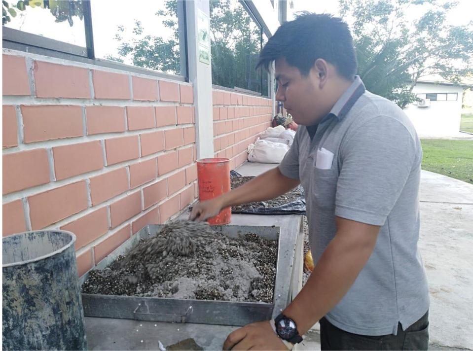
**Figura 45.** Mezclado de los materiales para el concreto ligero.
