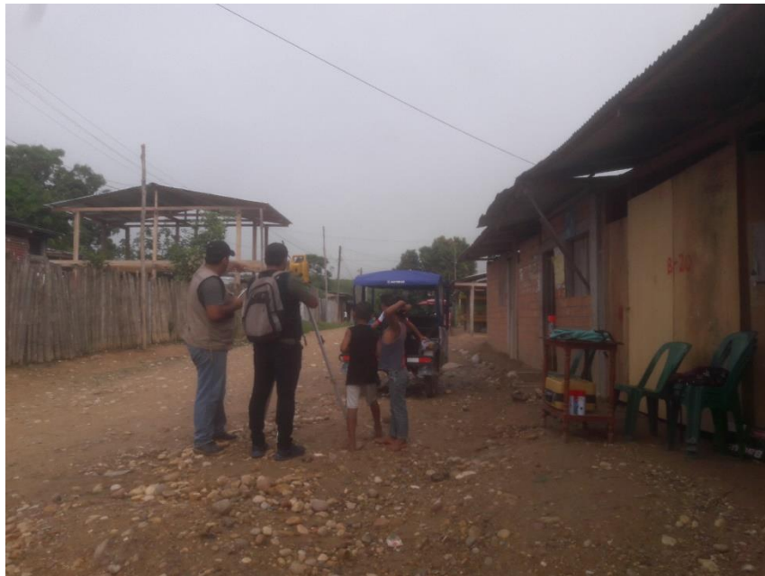
Se observa al tesista en el levantamiento topográfico de los sector colindantes
