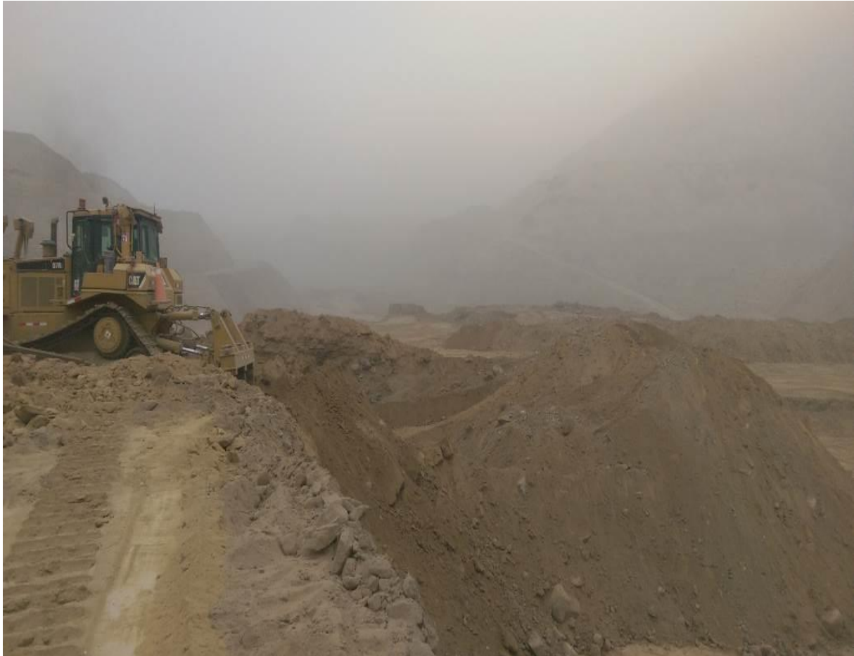
Gráfico 1 Máquina trabajando en el minado cortando material aluvial
