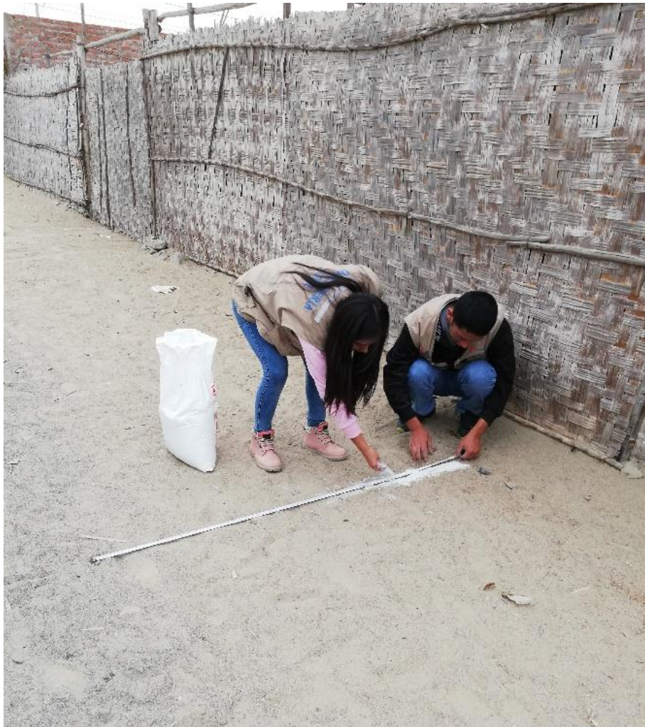
Fotografía N° 04: Se puede apreciar el trazo para las calicatas.
