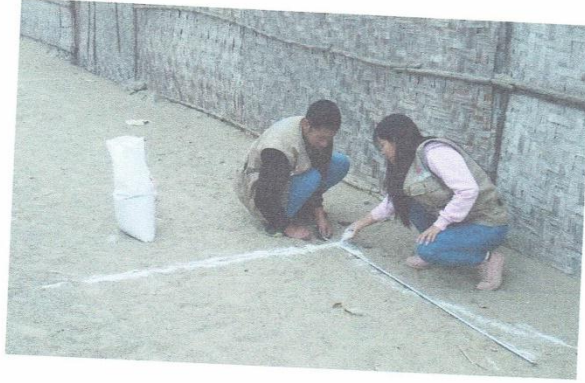
En la imagen se observa la realización del trazo para la excavación de la calicata, Asentamiento Humano Nueva Esperanza.
