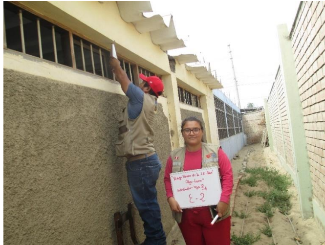
IMAGEN N° - 32: Ensayo de Esclerometría datos tomados en Viga 01
