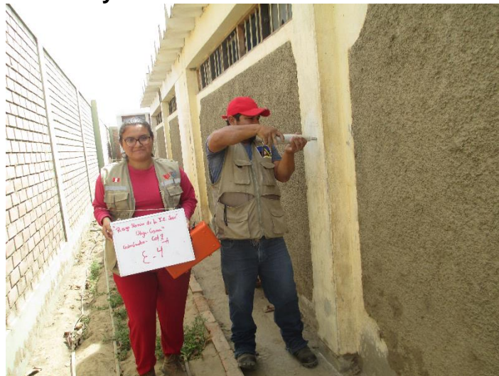
IMAGEN N° - 35: Ensayo de Esclerometría datos tomados en Columna 02
