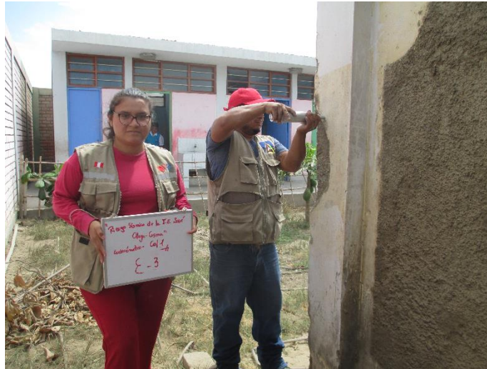
IMAGEN N° - 34: Ensayo de Esclerometría datos tomados en Columna 01
