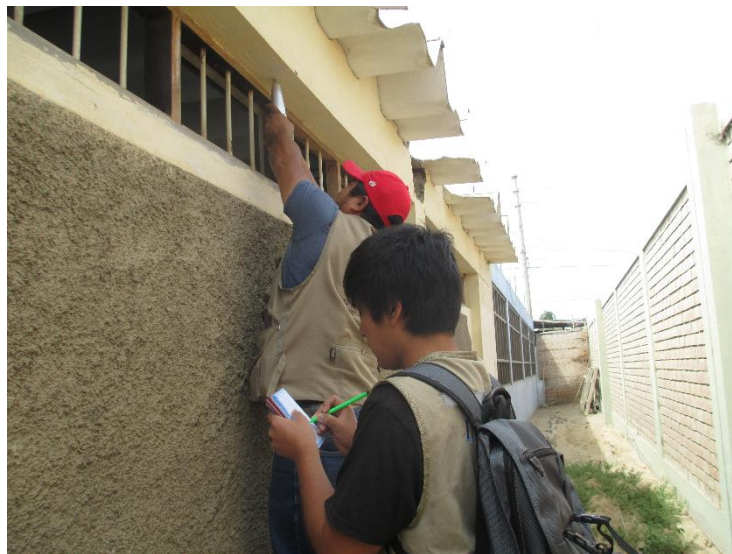
IMAGEN N° - 33: Ensayo de Esclerometría datos tomados en Viga 02
