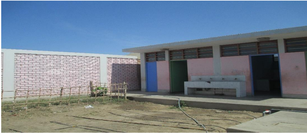
IMAGEN N° - 57: Vista del Tipo de Pendiente de la I.E. JOSÉ OLAYA
