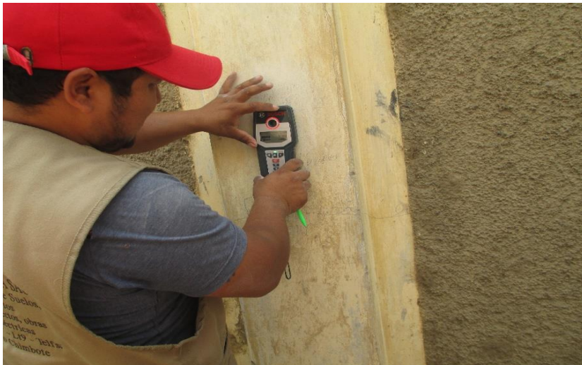
IMAGEN N° - 41: El ingeniero, mediante un escáner ubica en donde se encuentran los aceros del elemento para realizar un ensayo más preciso
