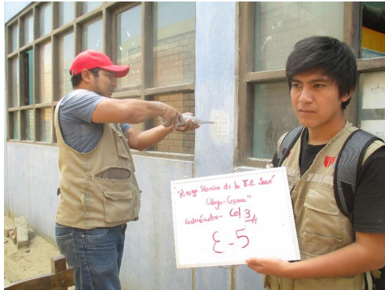
IMAGEN N° - 36: Ensayo de Esclerometría datos tomados en Columna 03
