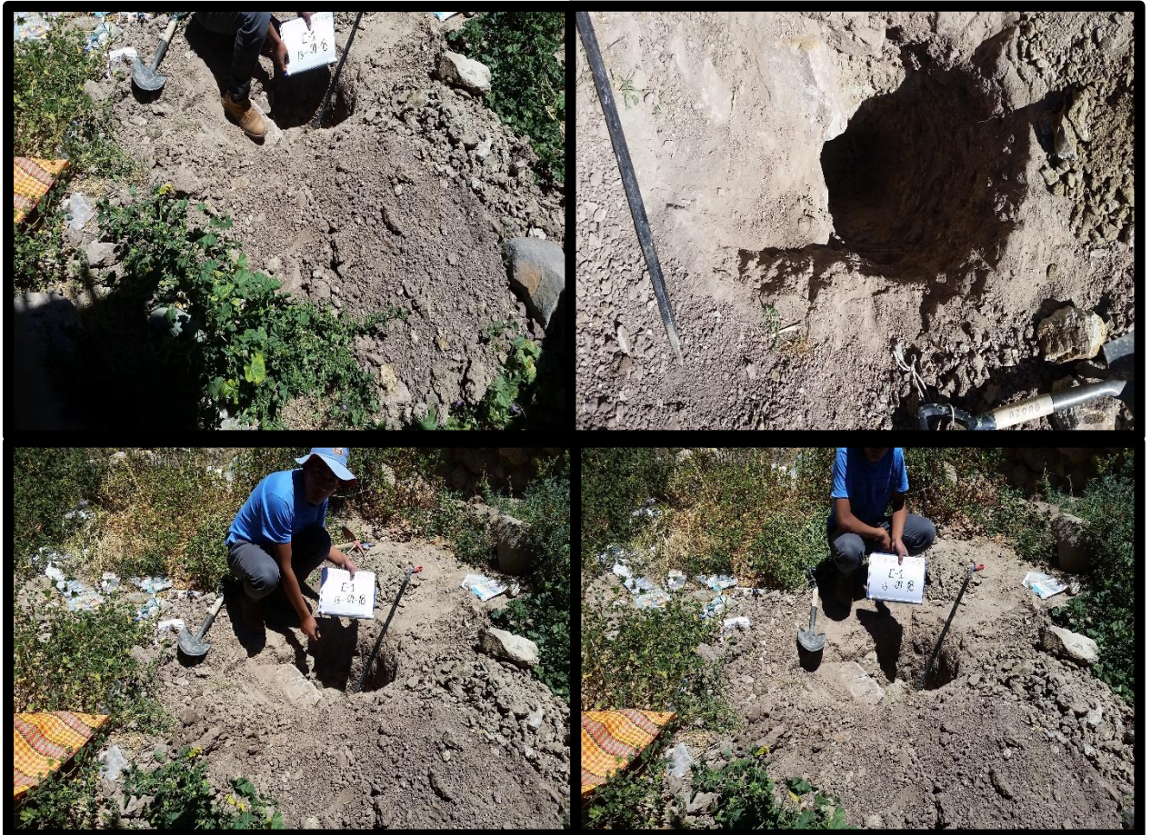
Figura 11: Excavación de Calicata
