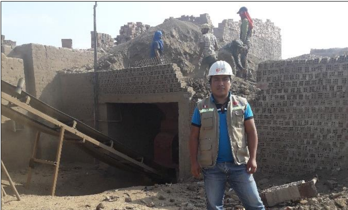
Figura 6. Molido del material, para el ladrillo maquinado.
