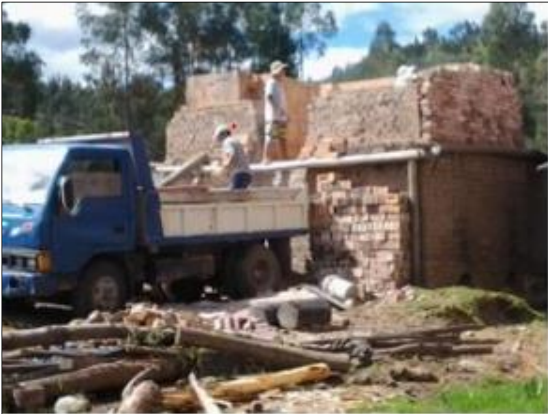
Figura 74. Descarga del ladrillo del horno.
