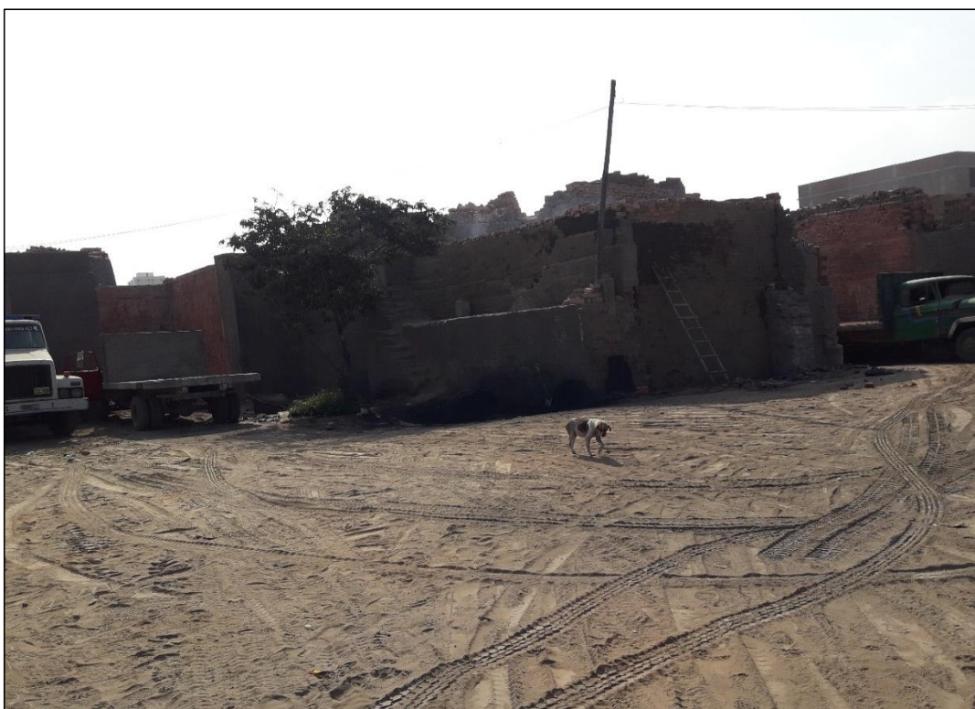
Figura 90. Proceso de cocción del ladrillo.
