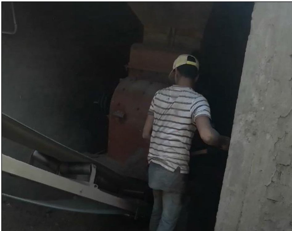
Figura 80. Parte baja del molino y expulsión del material.
