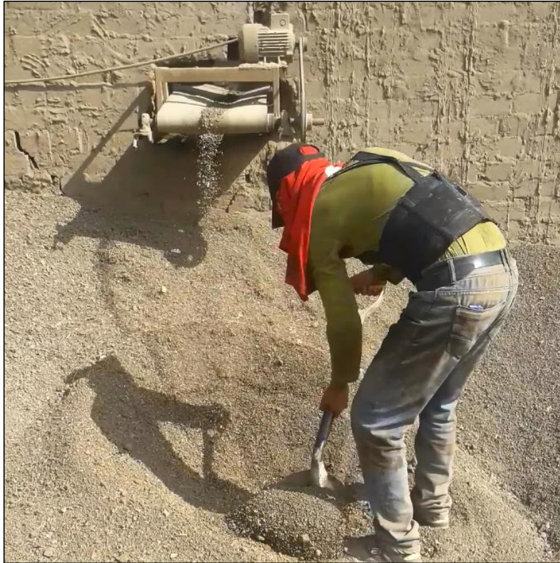
Figura 82. Proceso de expulsión del material grueso.
