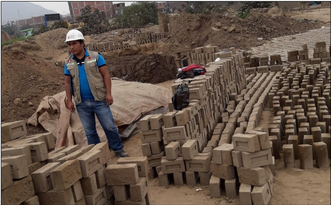
Figura 69. Volteo y filado a un costado de las unidades de albañilería.
