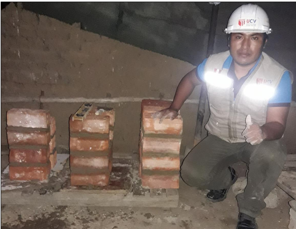
Figura 24. Construcción de las pilas.
