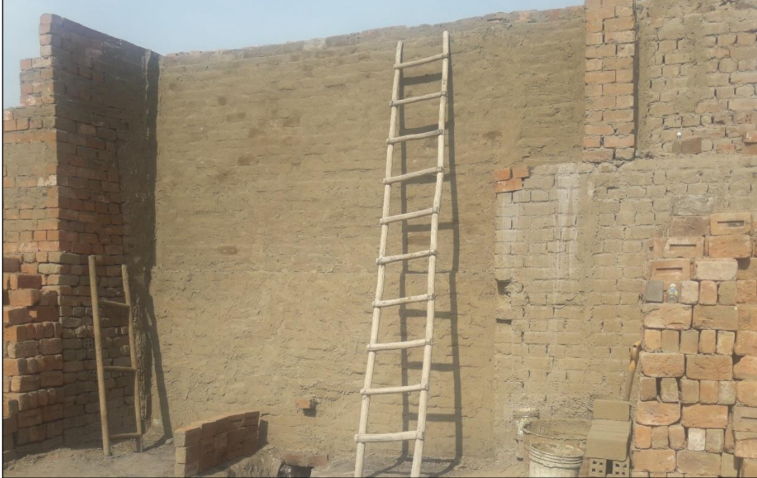
Figura 72. Tarrajeo de la parte frontal del horno.
