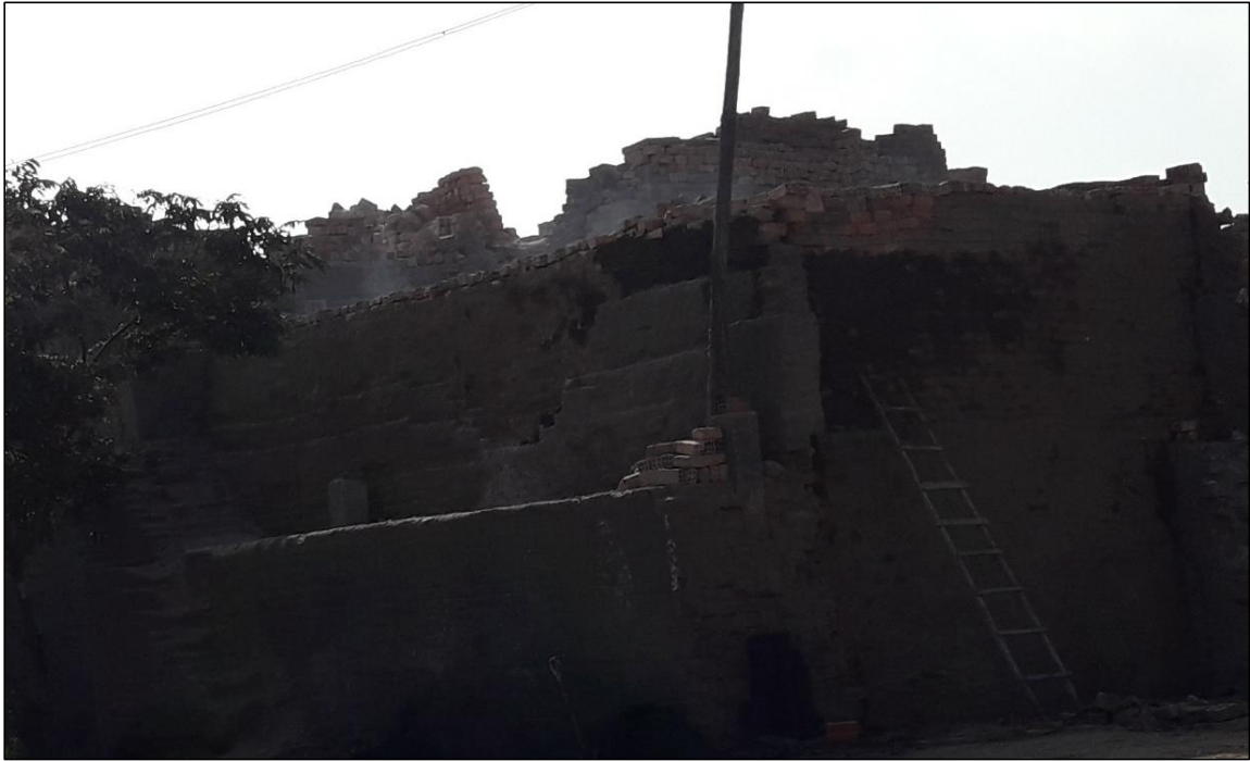
Figura 11. Proceso de cocción del ladrillo artesanal y maquinado.
