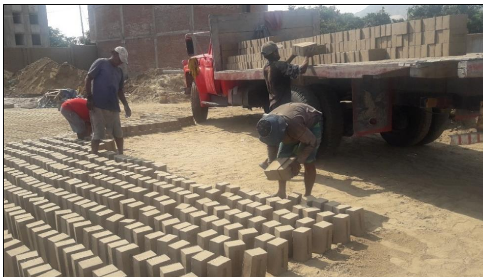
Figura 70. Cargado del ladrillo en camión del lugar de secado.
