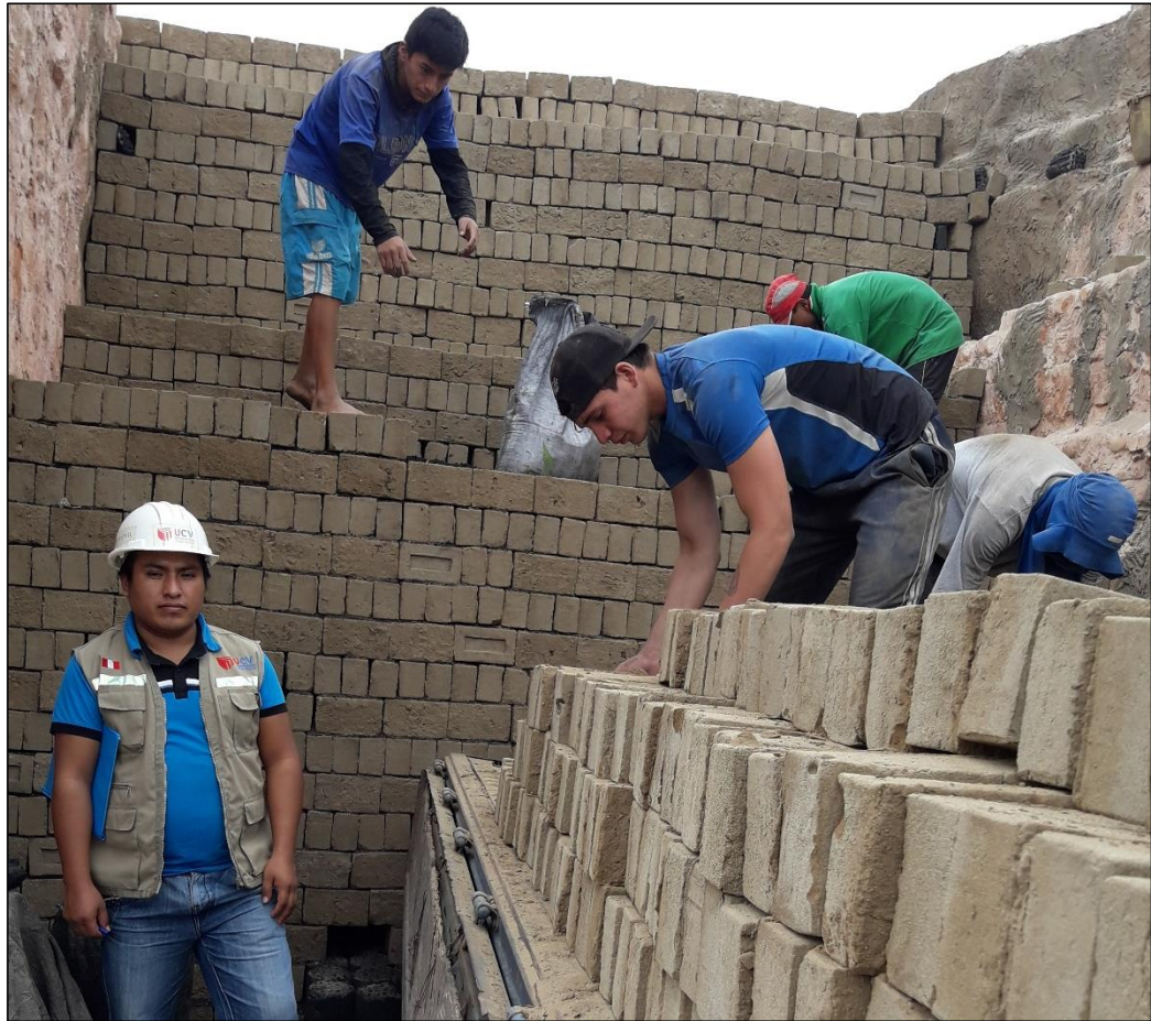
Figura 71. Llenado del ladrillo en el horno.
