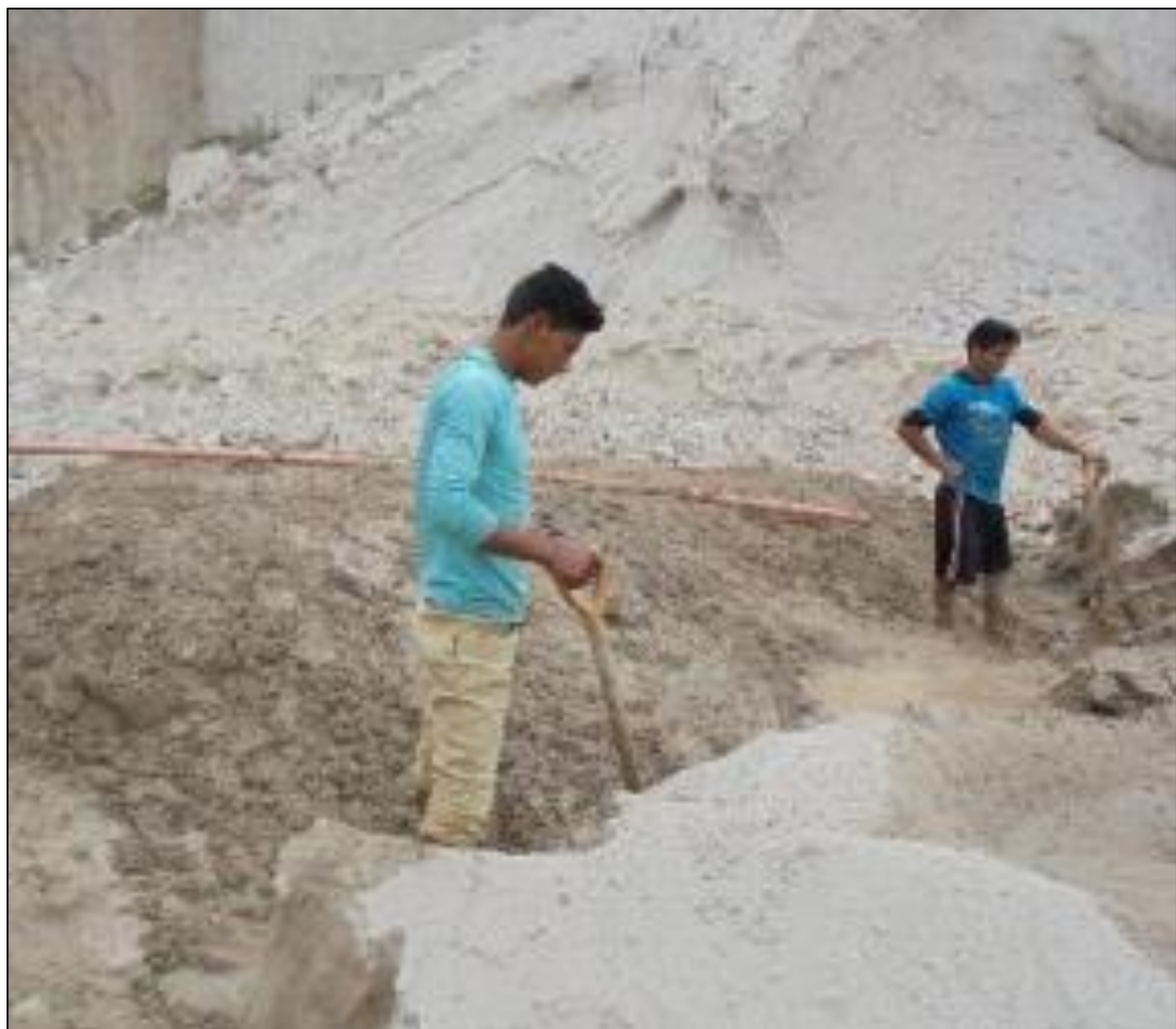
Figura 64. Preparación de la mezcla de forma manual.
