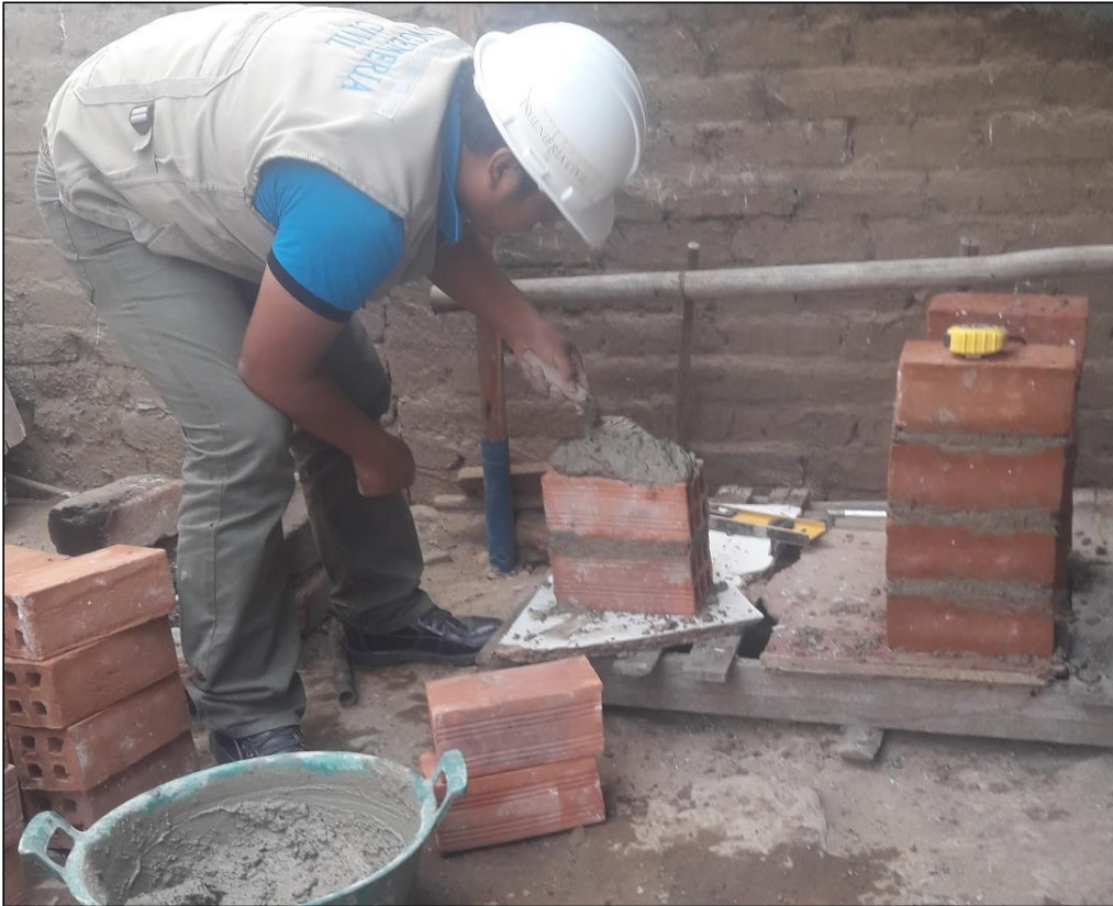
Figura 23. Construcción de las pilas, ladrillera 3.
