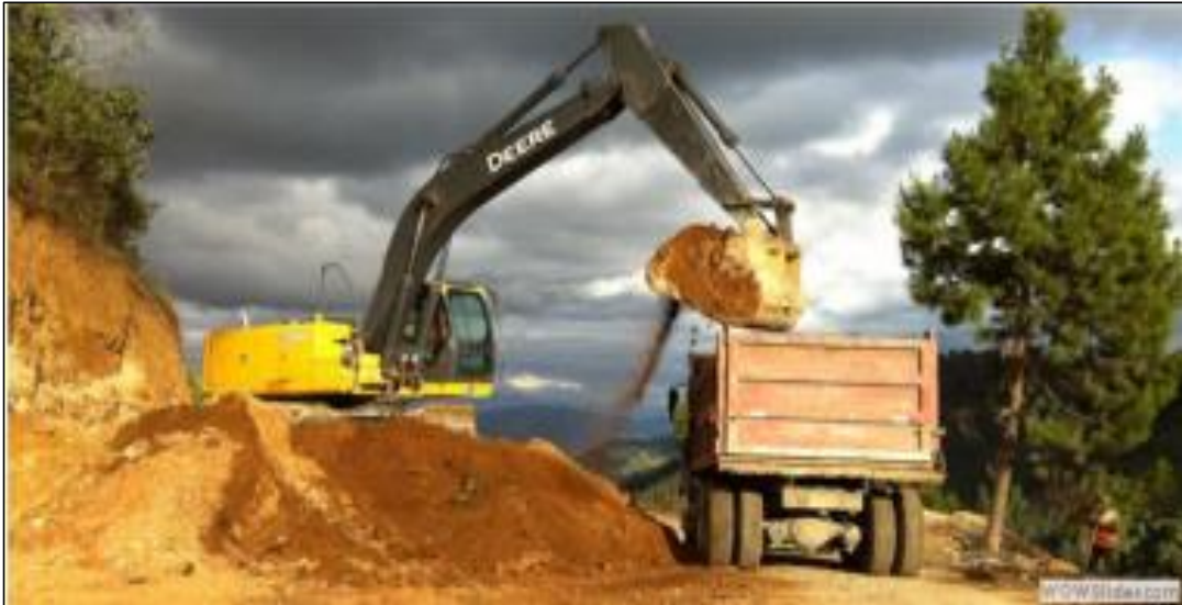
Figura 63. Proceso de extracción del material utilizando maquinaria pesada.
