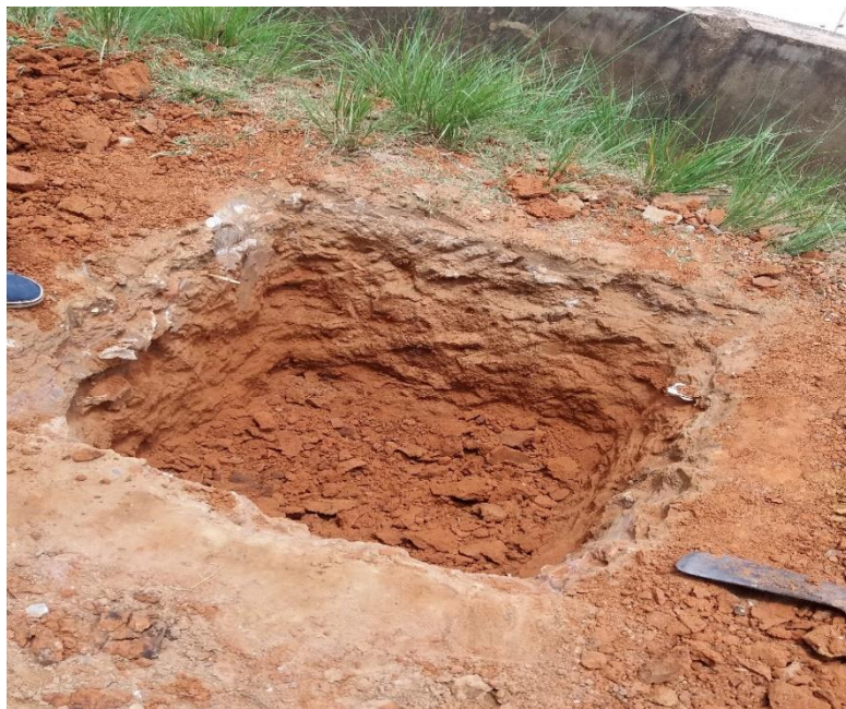
Imagen 40 Se puede observar la ubicación de la calicata n° 3 en la progresiva 0+080
