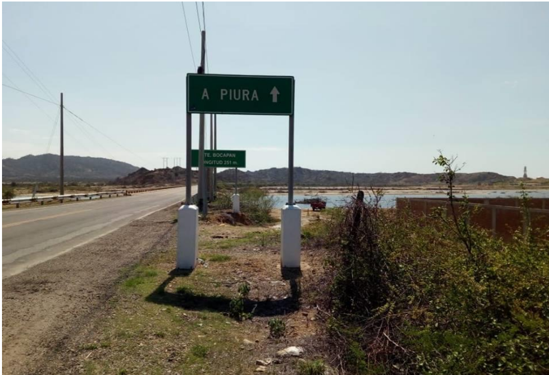
Puente de Bocapan
